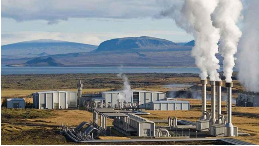
Şekil 2.4. Jeotermal Enerji Santrali (Anonim 2022e)
