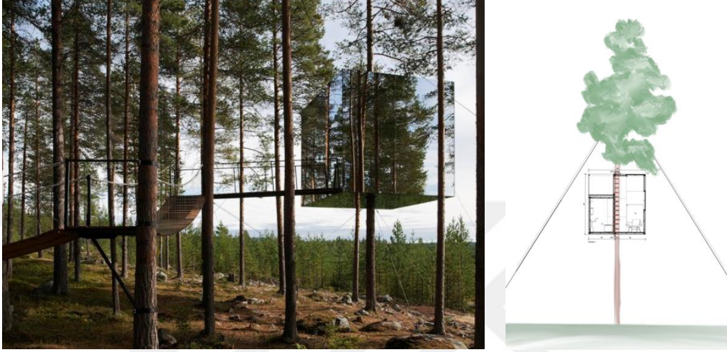
Şekil 4.19 Tree Hotel-Mirrorcube (sağda) (Lindman, 2008), Mirrorcube'ü taşıyan çelik halatlar ve kenetler (Tham & Videgard Arkitekter'in çizimlerinden uyarlanmıştır (Tham&Videgard, 2008).)
