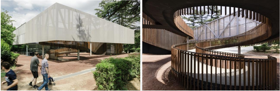
Şekil 4.45 Yarı-saydam cephe(solda) ve sarmal yol(sağda) - Mediatech Kültür Merkezi/Georgia (Nakanimamasakhlisi, 2017)
