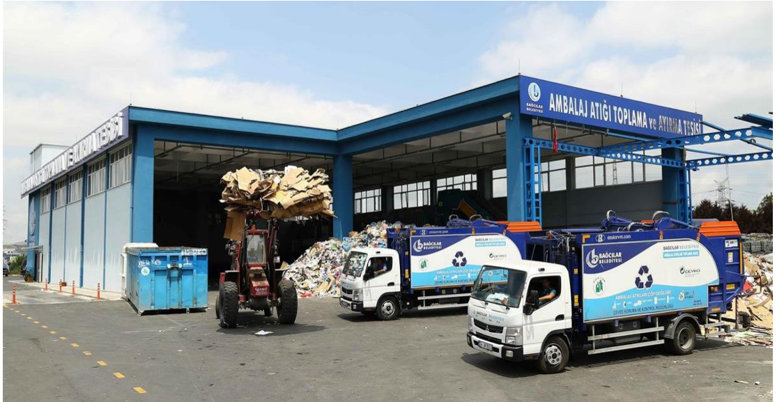
Şekil 3.19 Bağcılar belediyesi atık toplama ve ayırma tesisi (Bağcılar Belediyesi, 2016)
