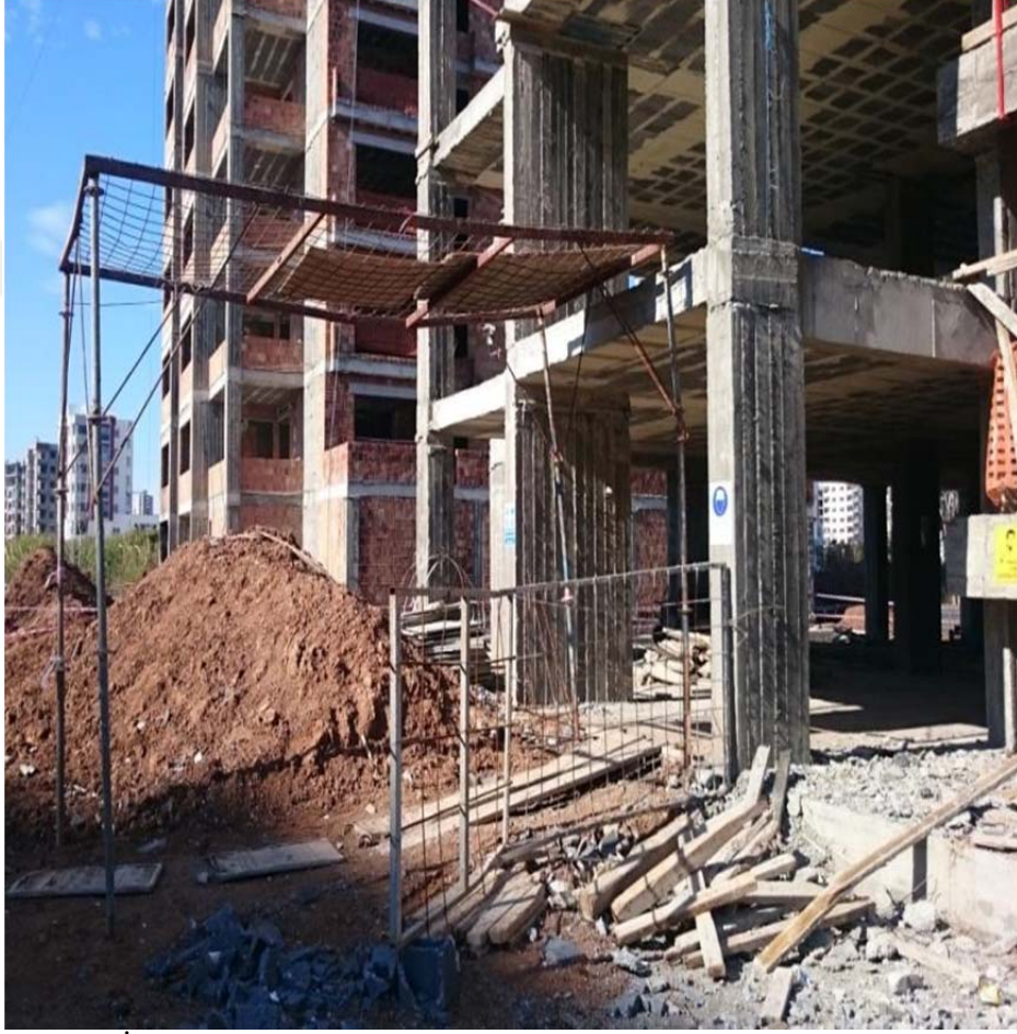
Şekil 4.21. İnşaat giriş – çıkış üzeri sundurma örneği
