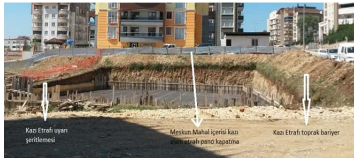
Şekil 3.2. Kazı etrafını kapatma örneği
