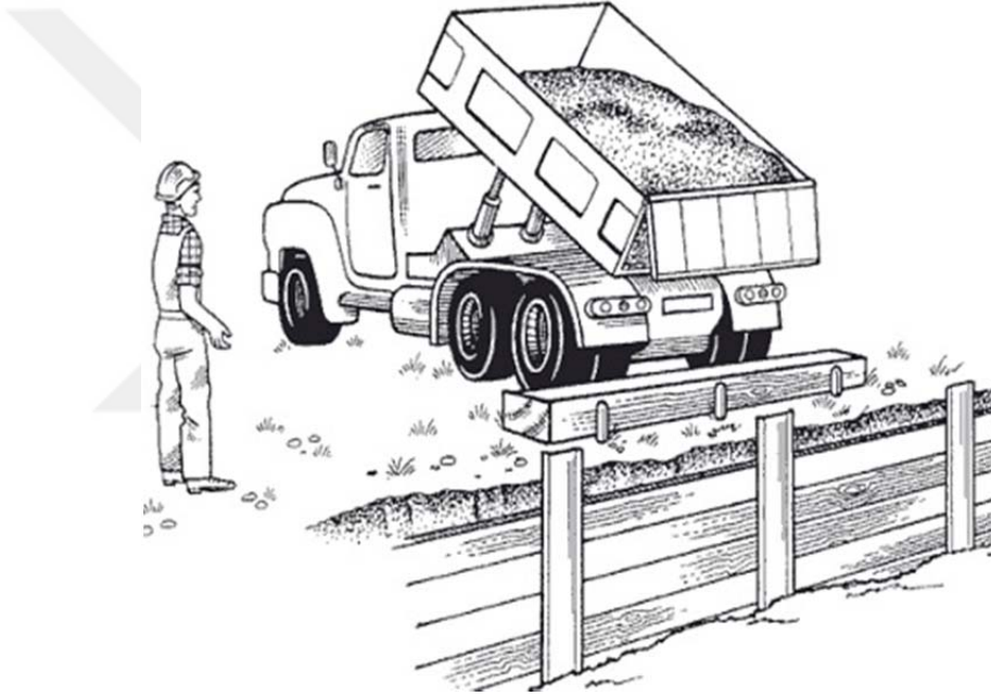
Şekil 3.7. Toprak boşaltılması sırasında araç takozlama örneği
