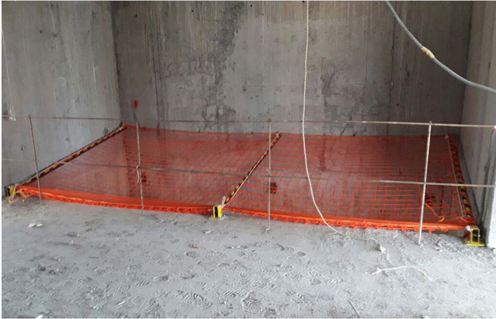
Şekil 4.12.b Asansör önü boşlukları kapatılma örnekleri
