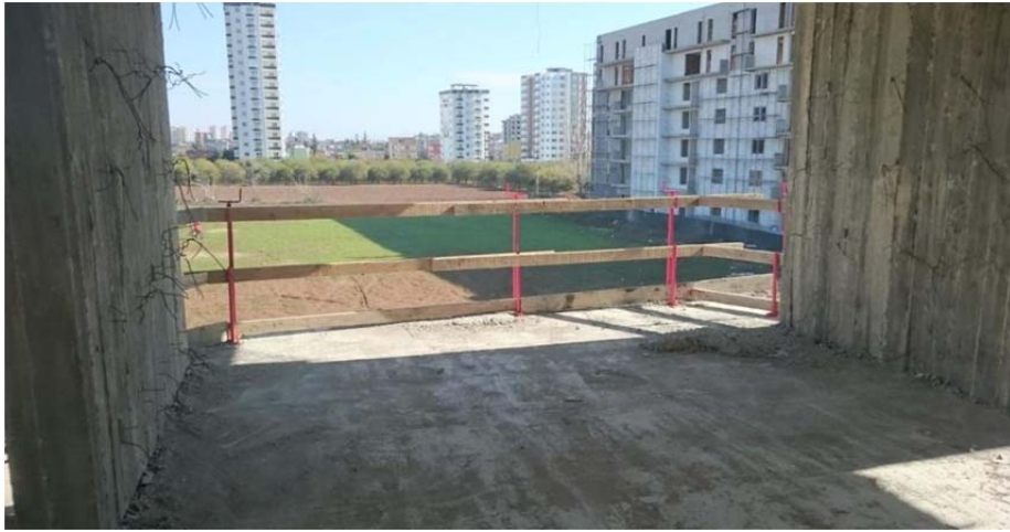
Şekil 4.25. İnşaat kat kenarı boşluğu kapatma örneği
