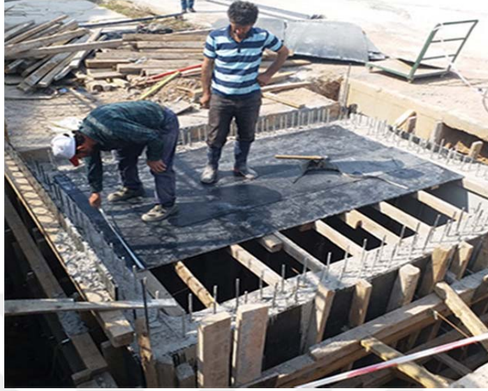
Şekil 3.9. Plywood kalıp örneği
