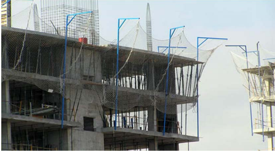
Şekil 3.36. V tipi güvenlik ağı uygulaması
