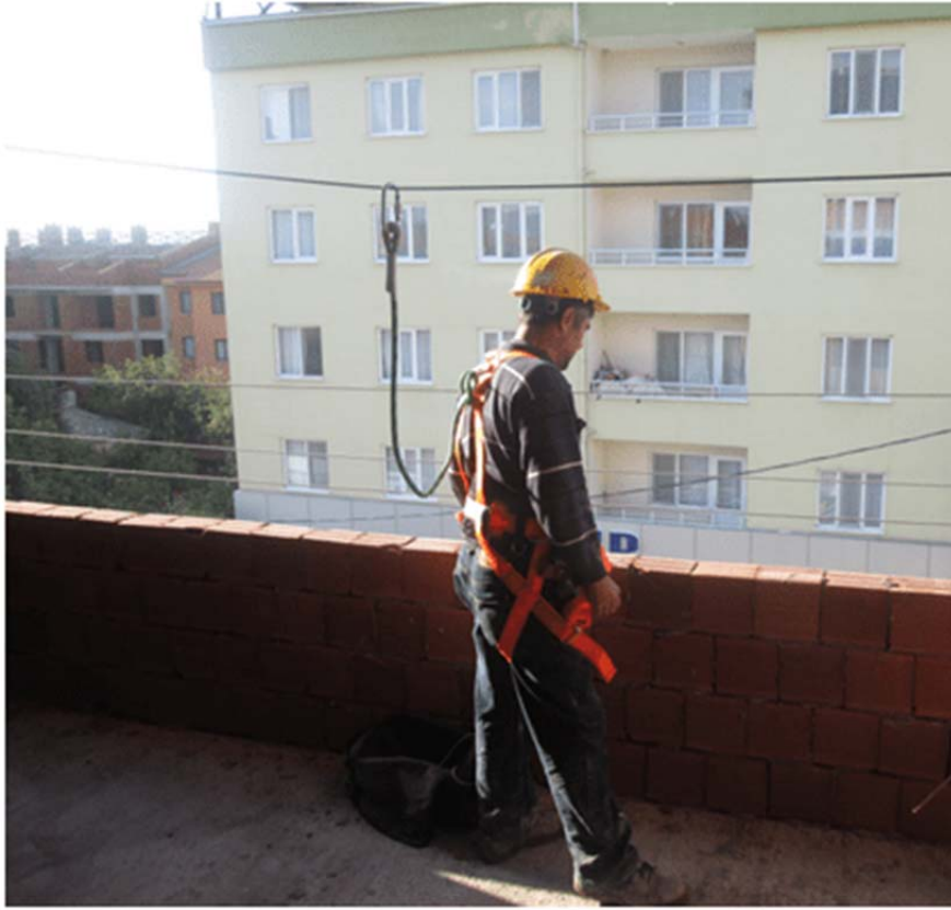
Şekil 3.38. Duvar örme işlemi paraşüt tipi emniyet kemeri kullanılması örneği
