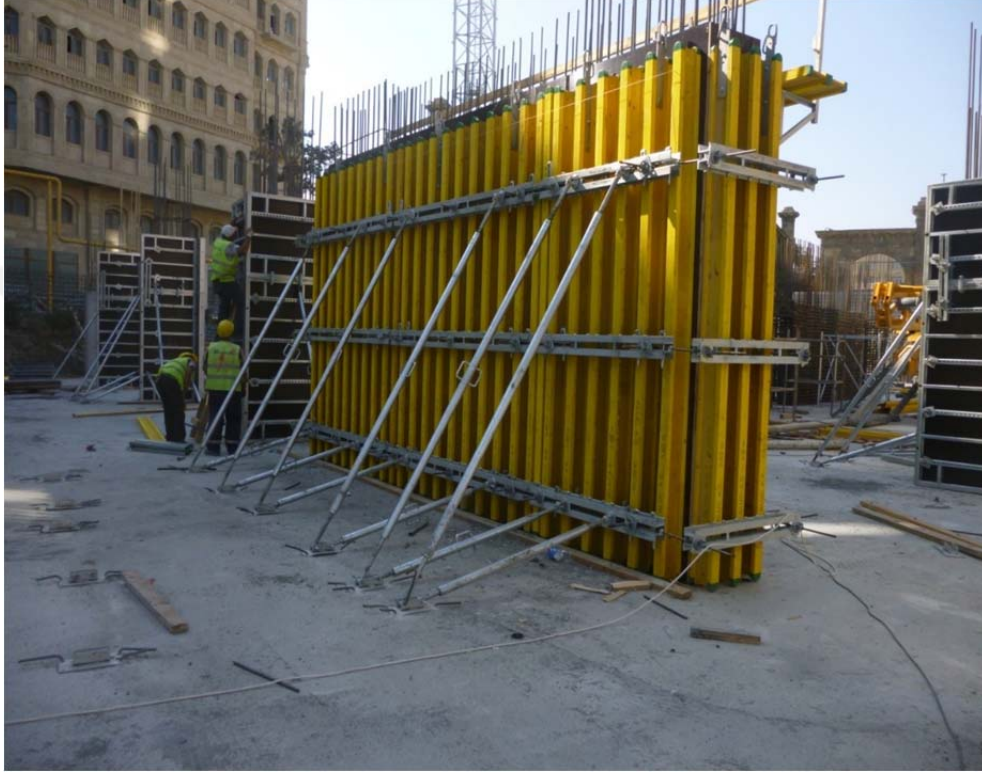
Şekil 3.8. Ahşap kirişli kalıp örneği
