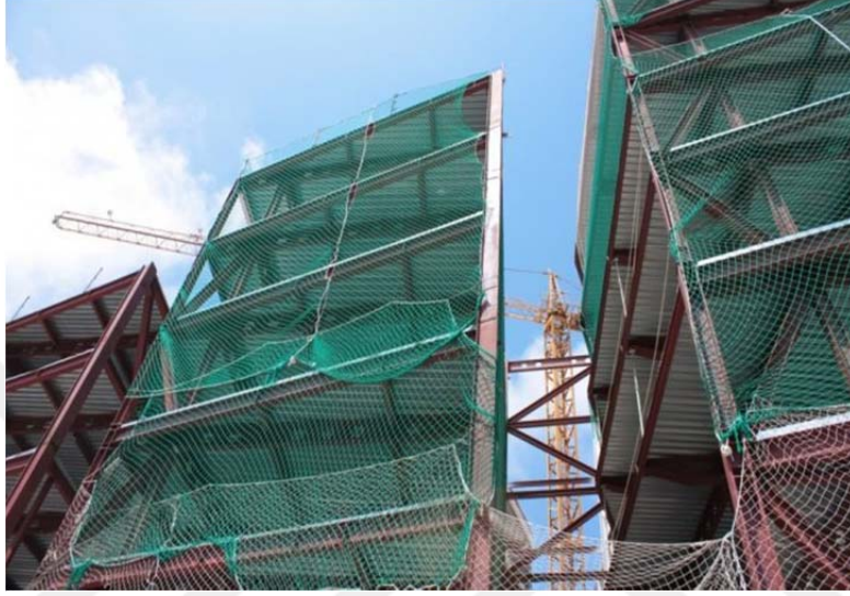
Şekil 3.35. U tipi güvenlik ağı uygulaması
