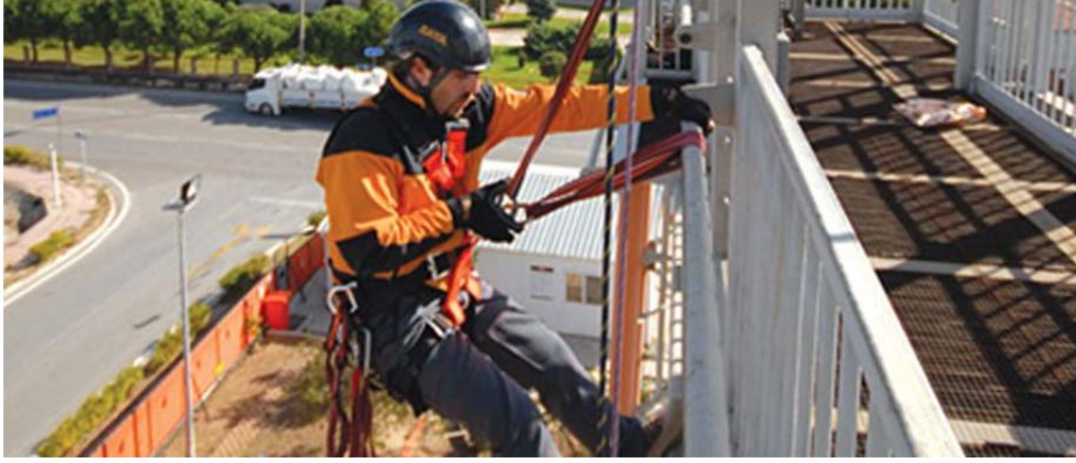
Şekil 3.15. Paraşüt tipi emniyet kemeri uygun noktalara bağlanması örneği
