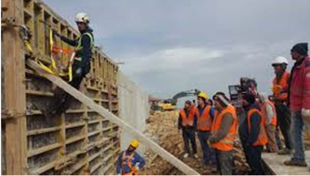
Şekil 3.16. Kalıp işinde paraşüt tipi emniyet kemeri uygulaması
