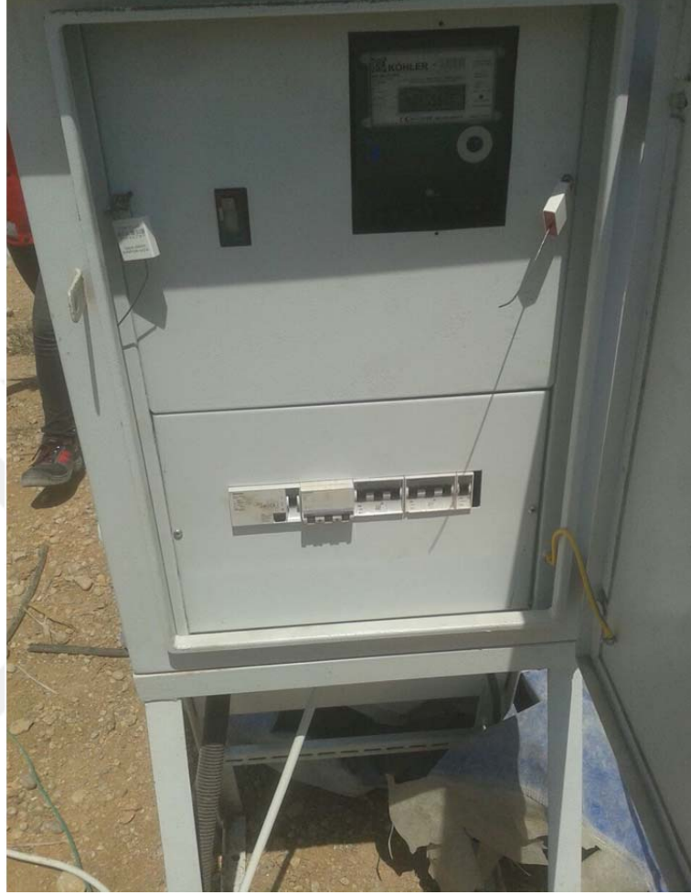
Şekil 4.31. Elektrik panosu iç koruma sacı örneği
