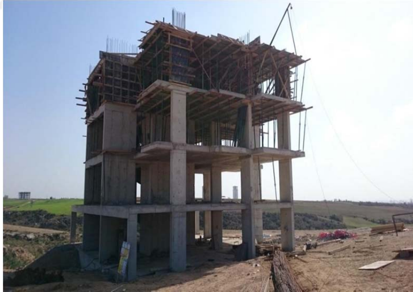
Şekil 4.20. B inşaatı giriş-çıkışların uygunsuzluğu
