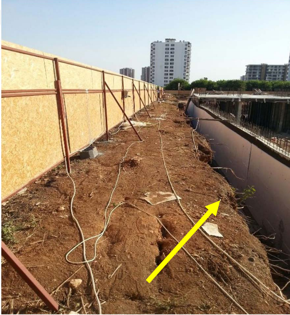
Şekil 4.3. A inşaatı kazı boşluk alanı
