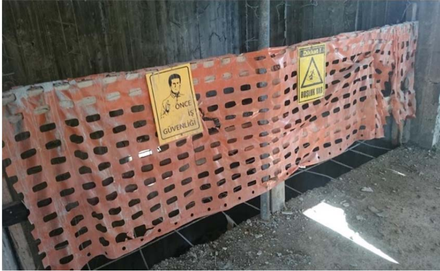
Şekil 4.27. Asansör boşluklarının kapatılması örneği
