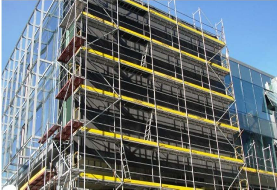
Şekil 3.22. Dış cephe iskelesi uygulaması
