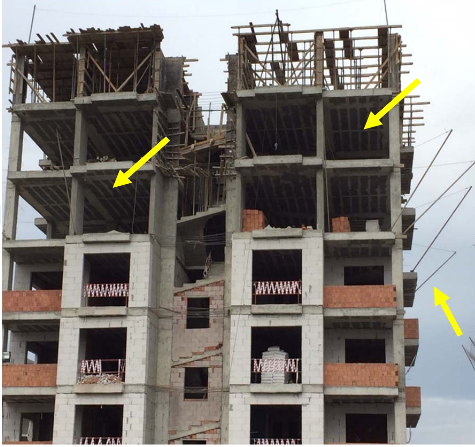
Şekil 4.17. A inşaatı genel görünümü
