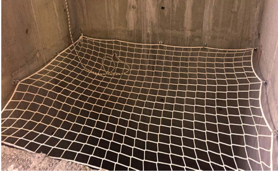
Şekil 3.32. Asansör boşluğunda S tipi güvenlik ağı uygulaması
