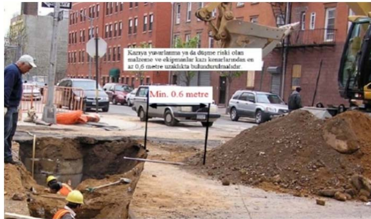
Şekil 3.4. Kazı çalışması bariyer örneği
