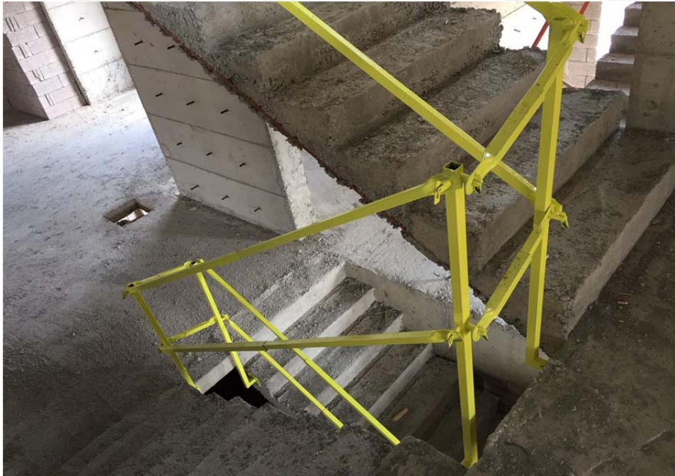
řekil 4.16.b Merdiven bořluęu kapatma rnekleri
