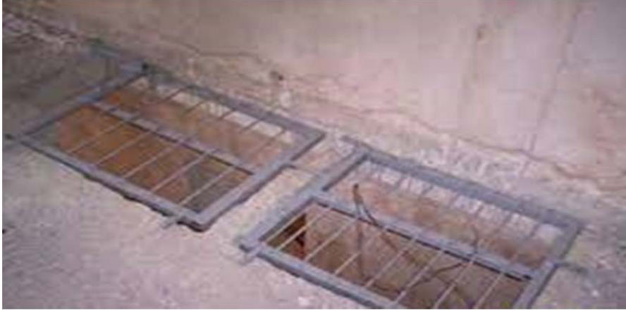
Şekil 4.9. Şaft boşlukları kapatma örnekleri
