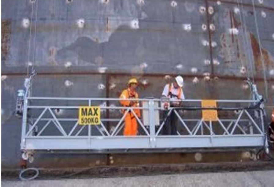
Şekil 3.27. Asma iskele üzerinde azami ağırlıkları asılı olmalı
