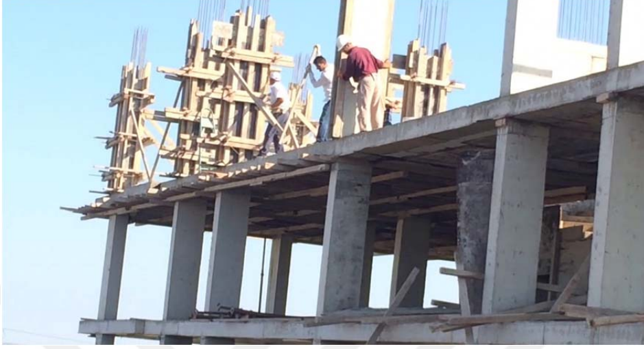
Şekil 3.12. Kalıp söküm örneği
