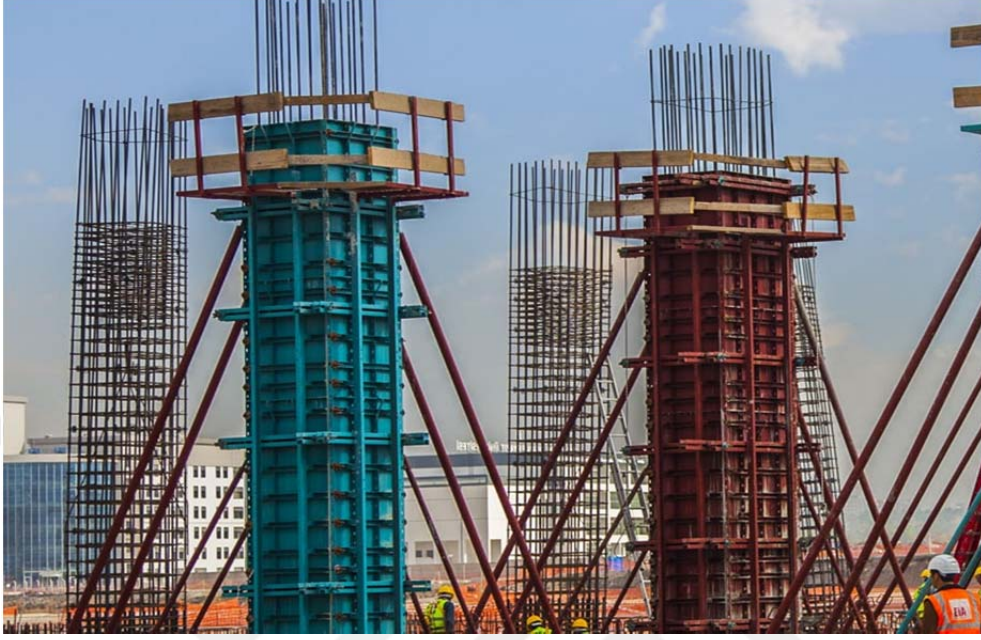
Şekil 3.11. Yüksek yapılarda çelik kalıp örneği
