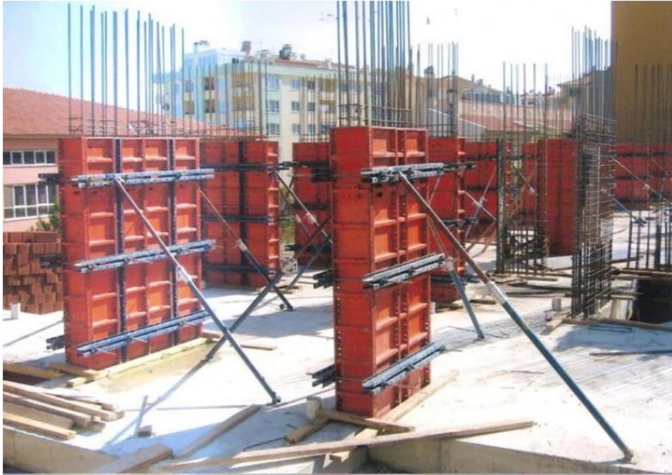
Şekil 3.10. Çelik kalıp örneği
