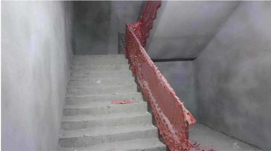
Şekil 4.29. Merdiven kenarları uygun kapatılması örneği
