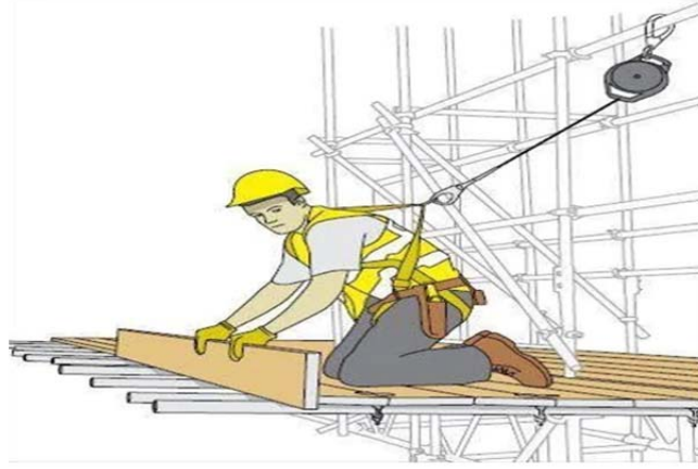
Şekil 3.14. Kalıp demir işlerinde paraşüt tipi emniyet kemeri örneği
