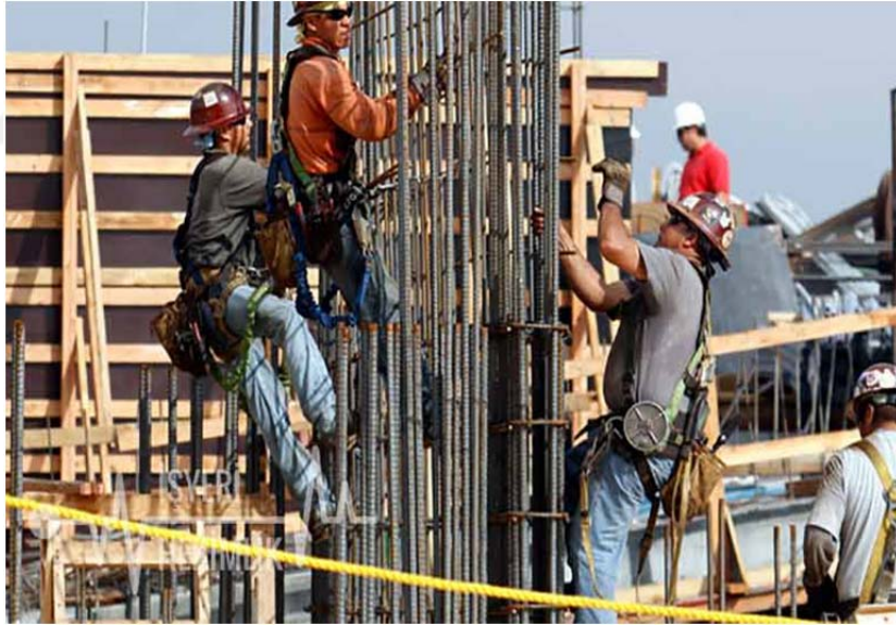
Şekil 3.17. Demir işinde paraşüt tipi emniyet kemeri uygulaması
