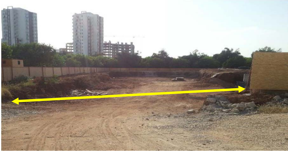
Şekil 4.1. A inşaatı nizamiye girişi
