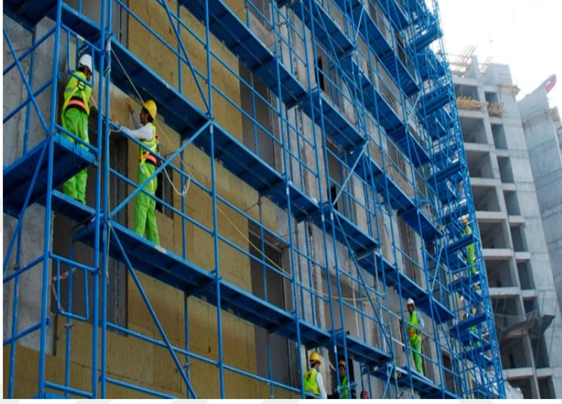
Şekil 3.24. Dış cephe iskelelerinde paraşüt tipi emniyet kemeri uygulaması
