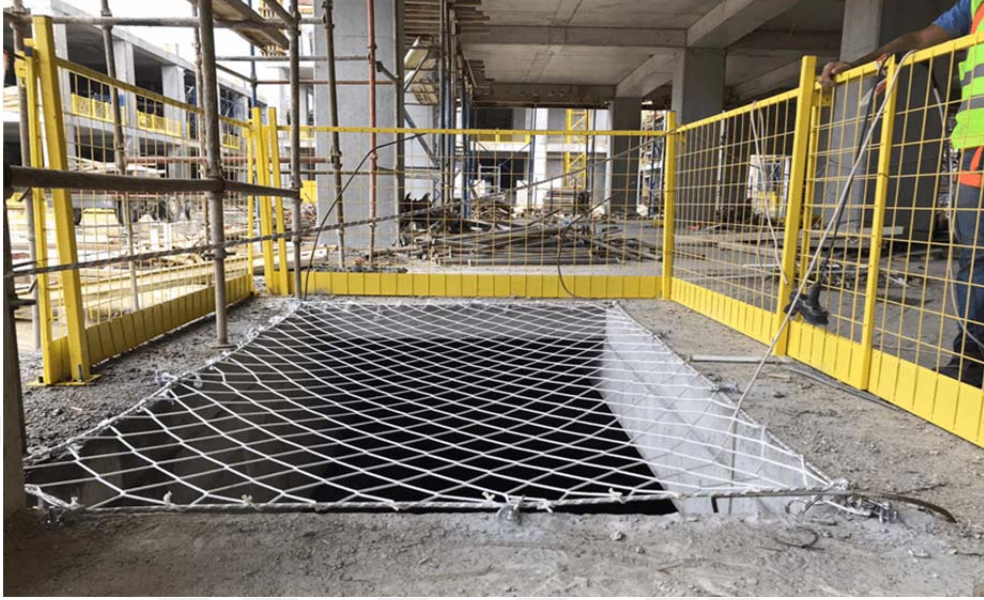
Şekil 3.33. Şaft boşluğunda S tipi güvenlik ağı uygulaması
