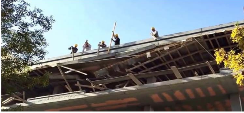
Şekil 3.13. Kalıp sökümü uygulaması
