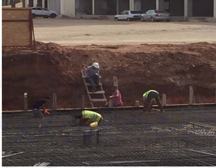
Şekil 4.5. A inşaatı merdiven kullanılması
