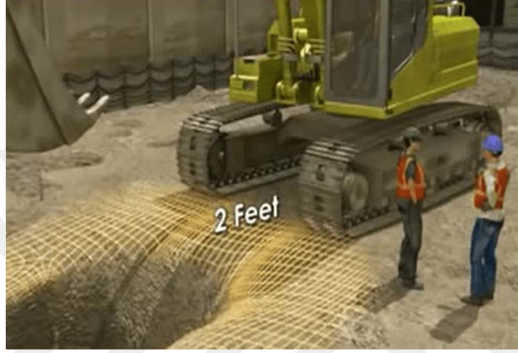
Şekil 3.5. Kazı çalışması mesafe örneği
