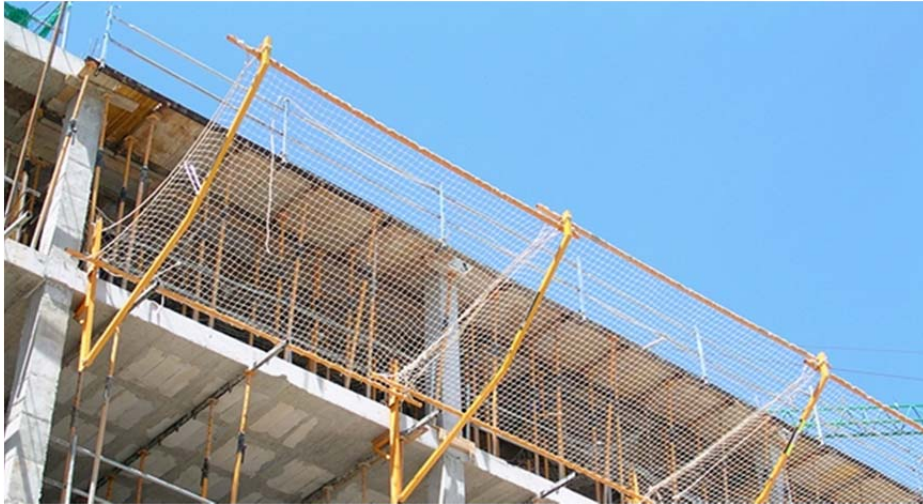
Şekil 3.34. T tipi güvenlik ağı uygulaması
