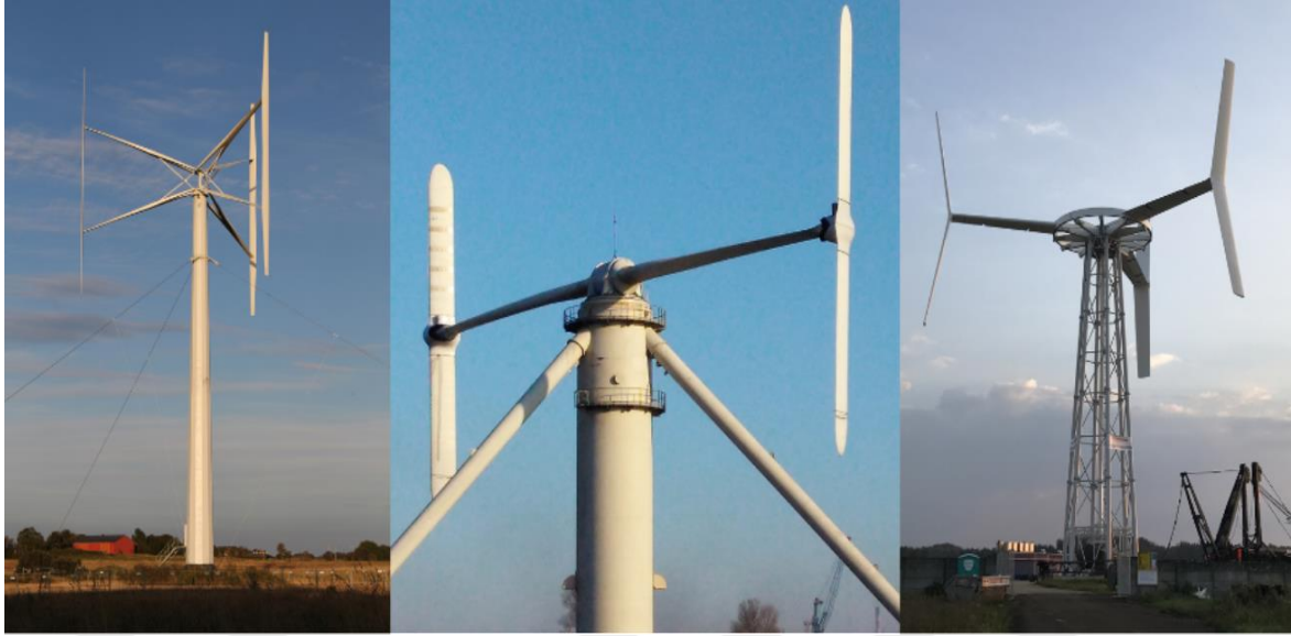
Resim 2.6. Farklı kanat sayılarına sahip H-Darrieus rüzgâr türbinleri [62]
