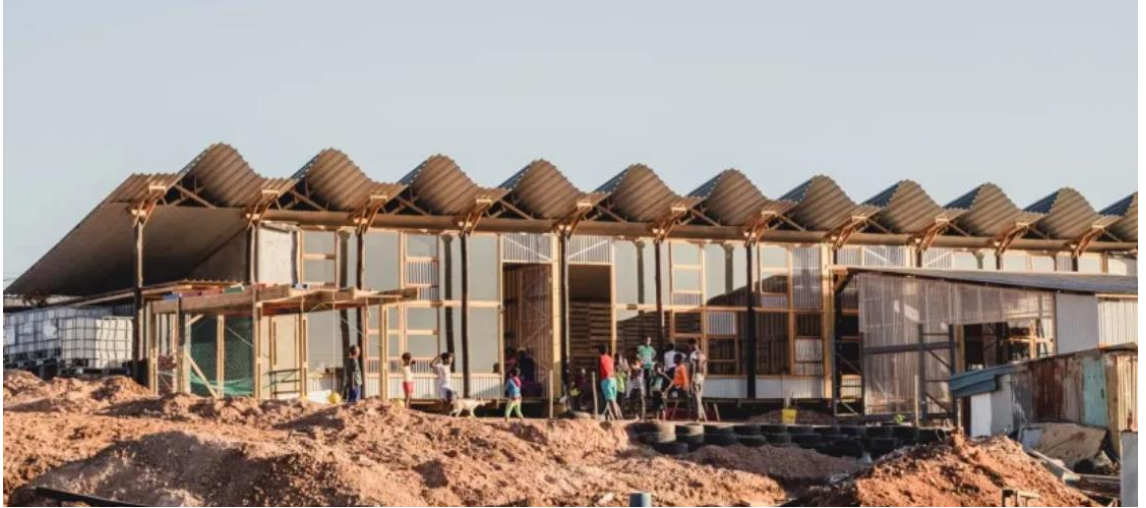
Şekil 29. Silindokuhle Anaokulu'na yapımına ait fotoğraf -2(URL-12)
