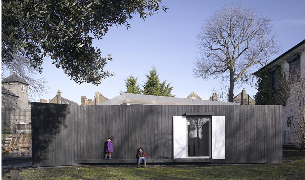
Şekil 22. Montpelier Kreşi'nin mevcut konut tarafına bakan cephesi-1 (URL-7)
