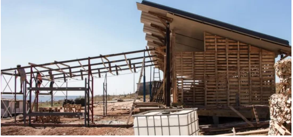
Şekil 30. Silindokuhle Anaokulu'na yapımına ait fotoğraf -3(URL-12)
