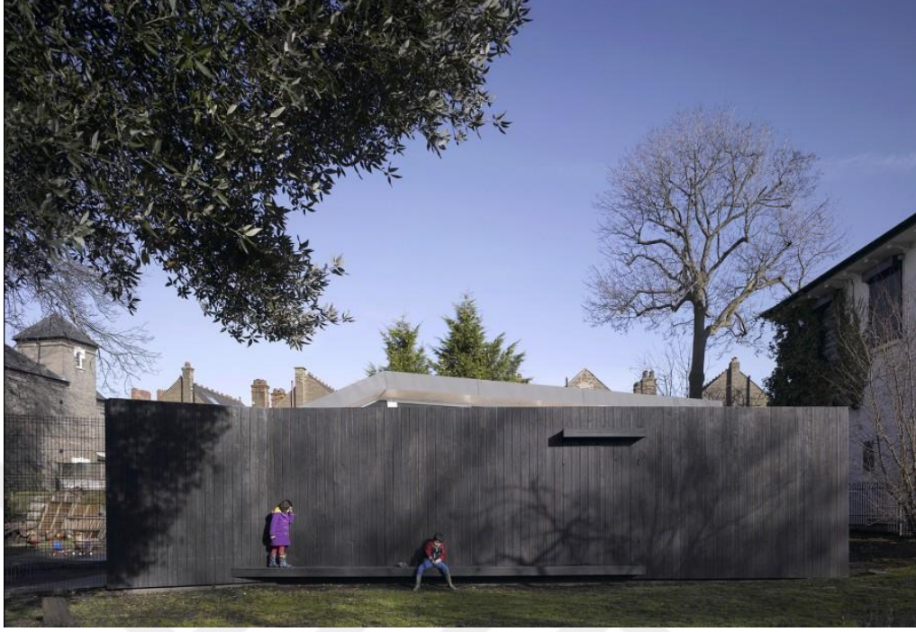
Şekil 23. Montpelier Kreşi'nin mevcut konut tarafına bakan cephesi-2 (URL-8)
