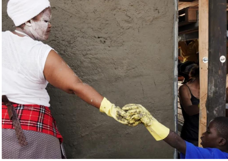
Şekil 28. Silindokuhle Anaokulu'na yapımına ait fotoğraf -1(URL-12)
