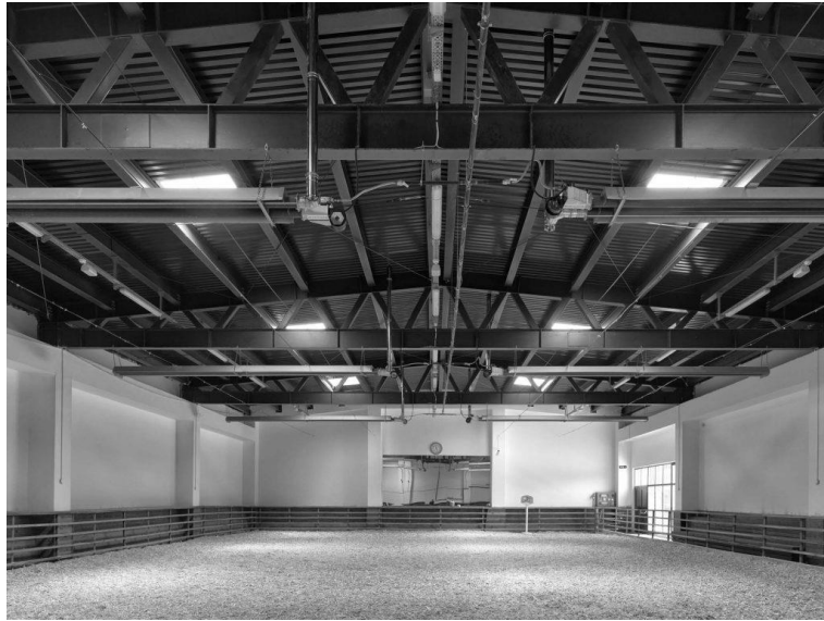
Şekil 35. SOBE Kapalı Manej Uzay Çatı Uygulaması
