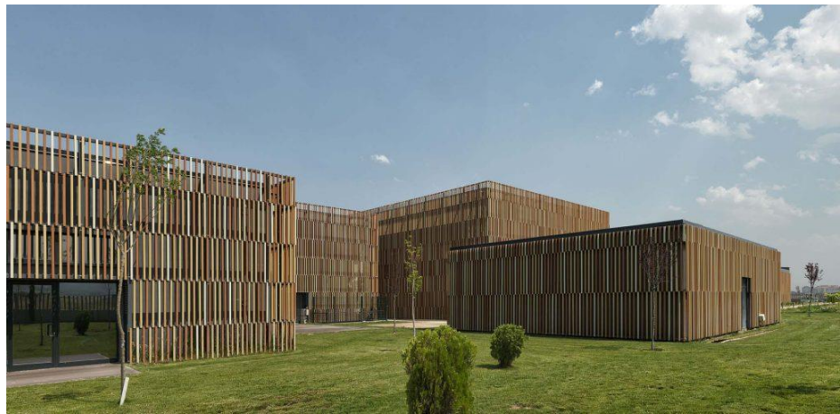
Şekil 19. SOBE Vakfı Terra-cotta Uygulaması
