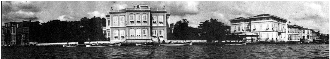
Şekil 8.18: Sait Halim Paşa Yalısı 1995 yangın öncesi denizden görünüşü (Avunduk, 2002)
