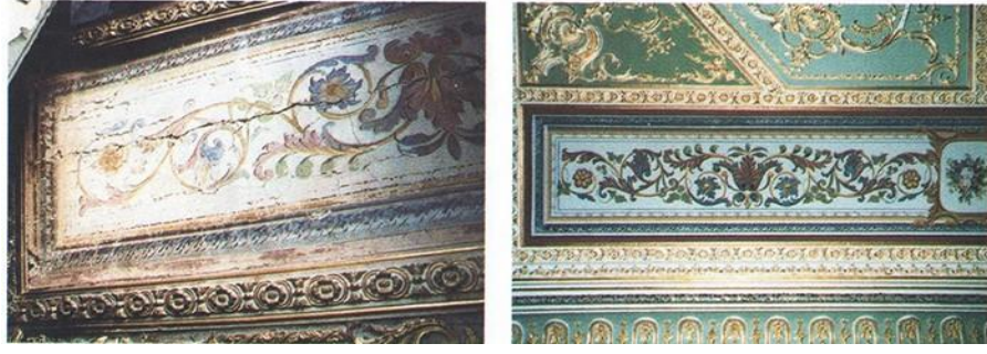
Şekil 8.26: 1. kat Altın Oda tavan süslemeleri, alçı kabartma ve kalem işleri Yangın sonrası ve restorasyon sonrası görünüşleri (Avunduk, 2002)
