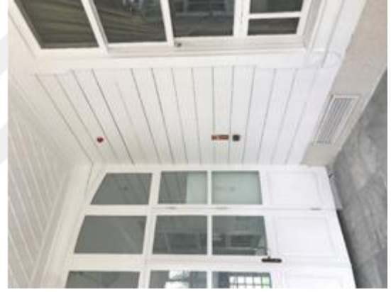
Şekil 6.37: Zemin kat kanal çıkışı
