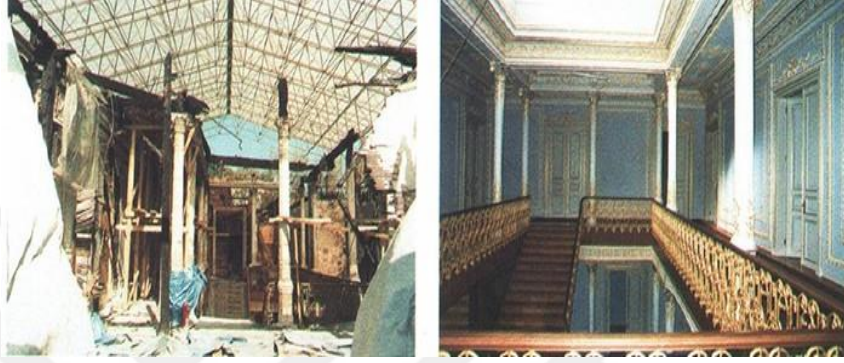
Şekil 8.24: 1. kat merdiven holü yangın sonrası ve restorasyon sonrası görüşleri (Avunduk, 2002)
