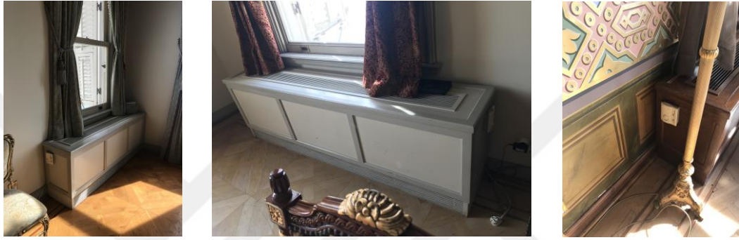
Şekil 8.41: Pencere altlarına konumlandırılmış ‘fan-coil’ sistem cihazı
