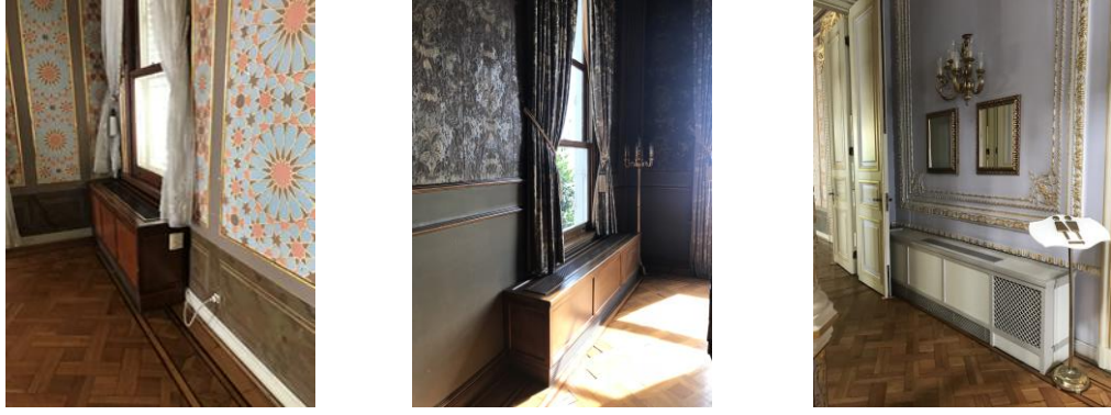
Şekil 8.40: Pencere altı ve kapı arkası konumlandırılmış ‘fan-coil’ sistem cihazı
