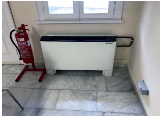
Şekil 6.46: Bodrum kat bekleme odası (fan coil)
