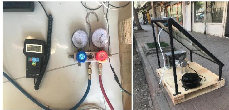
Şekil 4.8.Kompresör montajı ve gaz basım işlemi
