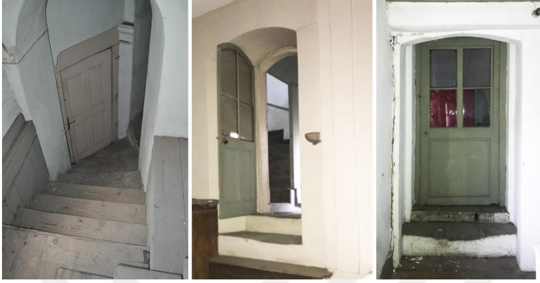
Şekil 4.67 : Kilise beden duvarı üzerinde açılan geçiş boşlukları soldan sağa doğru: boşluk arkasında nartekse açılan kapı, galeri katı ve koro katı giriş kapıları (Güçlü Prifti, 2017).
