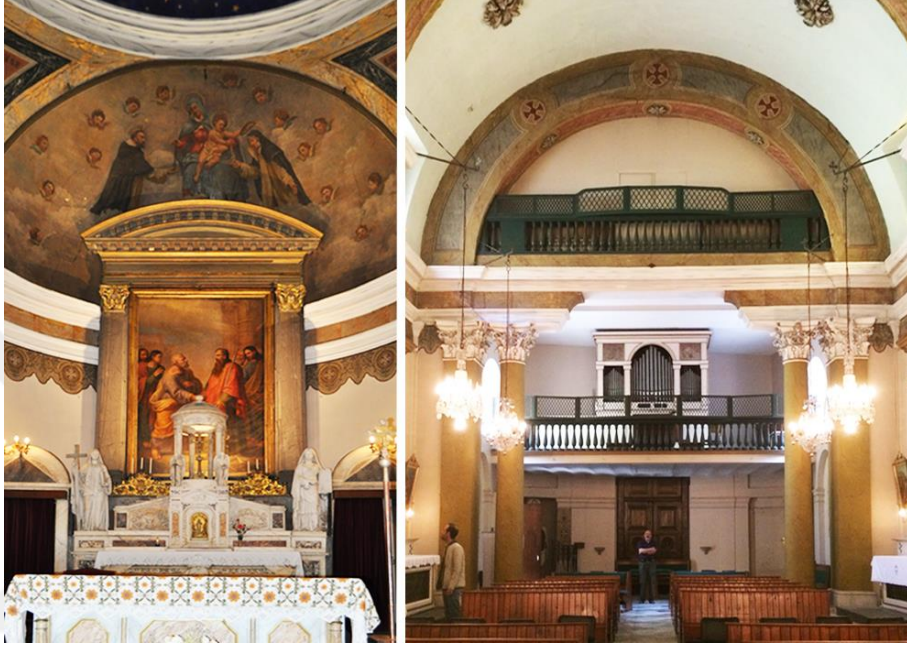
Şekil 4.61 : Solda apsiste kesintiye uğrayan silme hattı, sağda koro katı altında org hizasındaki yükseklik değişimi (Güçlü Prifti, 2017).
