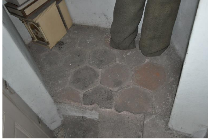
Şekil 5.9 : Özgün merdiven alanında sonradan kaplanmış şeshane tuğlası (Güçlü Prifti, 2017).
