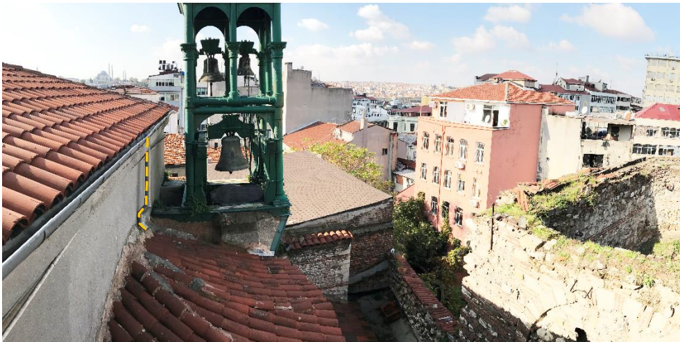
Şekil 4.81 : Bema çatısından apsis çatısına inen yağmur suyu borusu (Güçlü Prifti, 2017).
