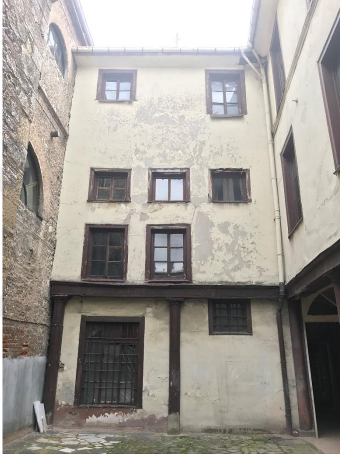
Şekil 6.3 : 1 numaralı ek yapının ikinci avluya bakan cephesi (Güçlü Prifti, 2017).
