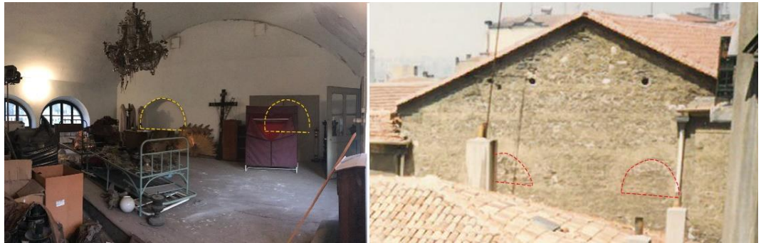
Şekil 4.70 : Solda koro katı iç mekânından kapatılan pencerelere bakış (Güçlü Prifti, 2017), sağda dış cepheden pencerelerin görünümü (SPPKA).
