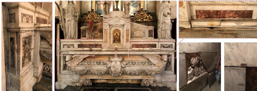
Şekil 4.76 : Korozyonun ana altarda neden olduğu hasarlar (Güçlü Prifti, 2017).
