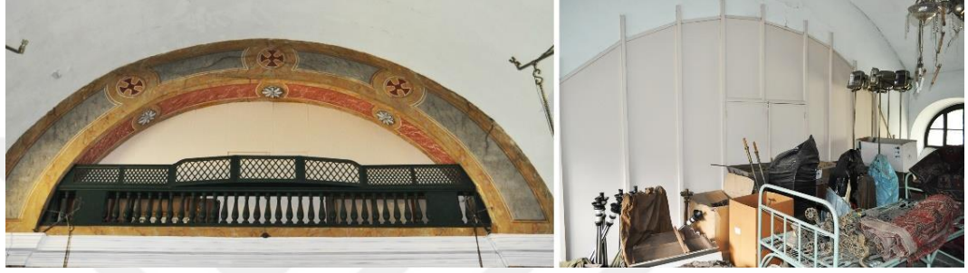
Şekil 4.69 : Solda naostan koro katına bakış, sağda koro katından naos yönüne bakış, kapatılan açıklık (Güçlü Prifti, 2017).
