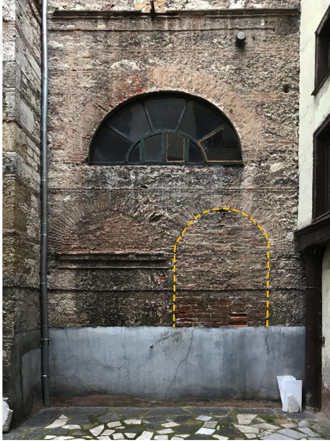
Şekil 4.68 : İkinci avlu üzerinde kapatılan kapı boşluğu (Güçlü Prifti, 2017).
