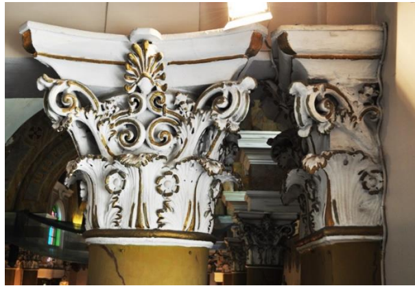
Şekil 4.60 : Yapı içerisinde korint sütun başlığı (Güçlü Prifti, 2017).
