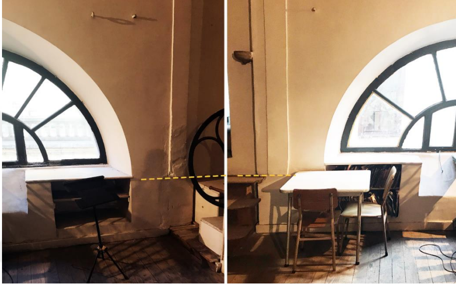
Şekil 5.14 : Solda kuzeydoğu beden duvarı, sağda güneybatı beden duvarı üzerindeki pilastr (Güçlü Prifti, 2017).
