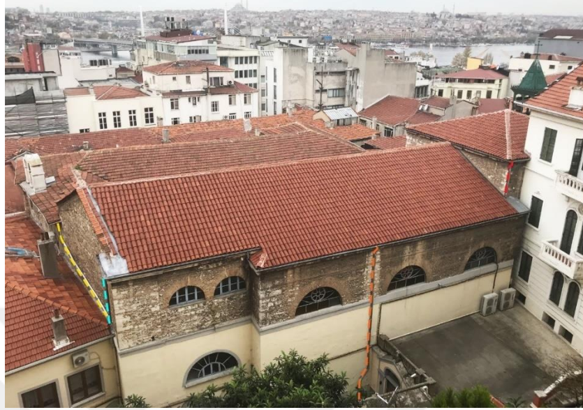
Şekil 4.78 : Kilise kuzeydoğu cephesi üzerindeki yağmur suyu iniş boruları (Güçlü Prifti, 2017).
