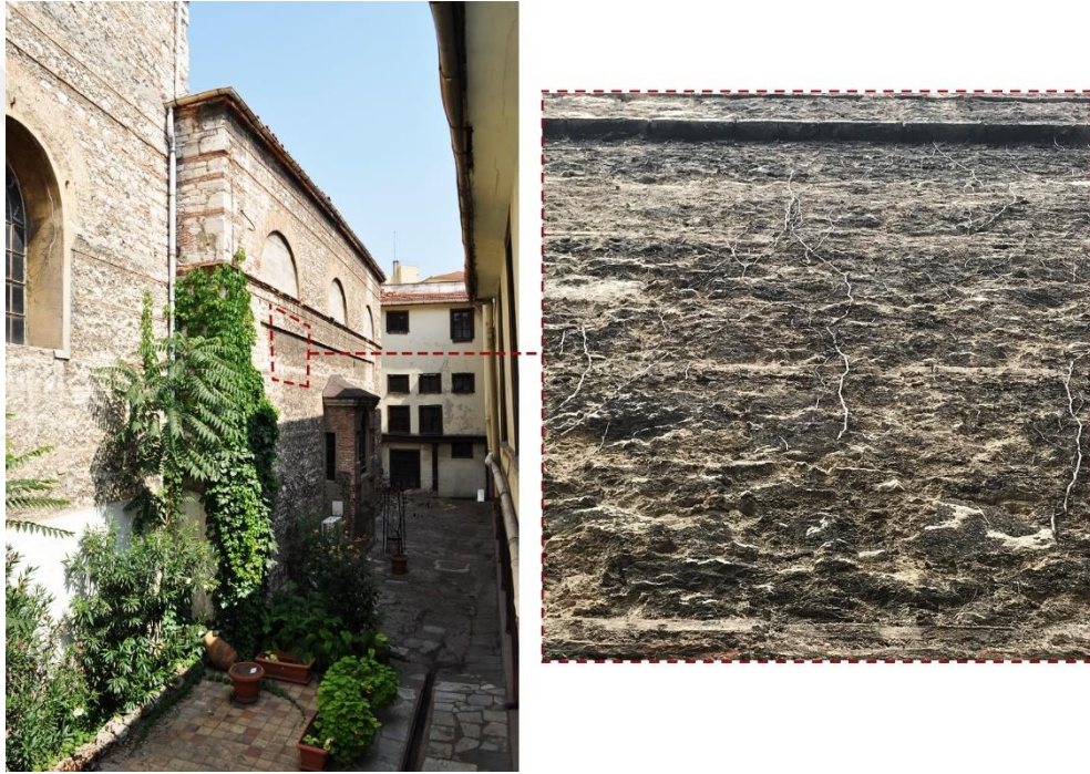
Şekil 6.5 : İkinci avlu üzerinde cepheye tutunarak büyüyen bitki ve kalıntıları (Güçlü Prifti, 2016).
