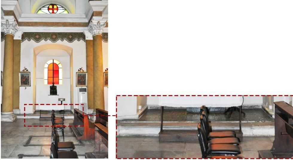
Şekil 6.4 : Özgün döşeme üzerindeki karo kaplama (Güçlü Prifti, 2017).
