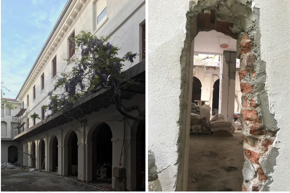
Şekil 4.10 : Saint Pierre Frer Okulu’ndaki restorasyon çalışmaları sırasında kilise yapı topluluğuyla arasındaki duvarda geçiş için açılan boşluk (Güçlü Prifti, 2017).
