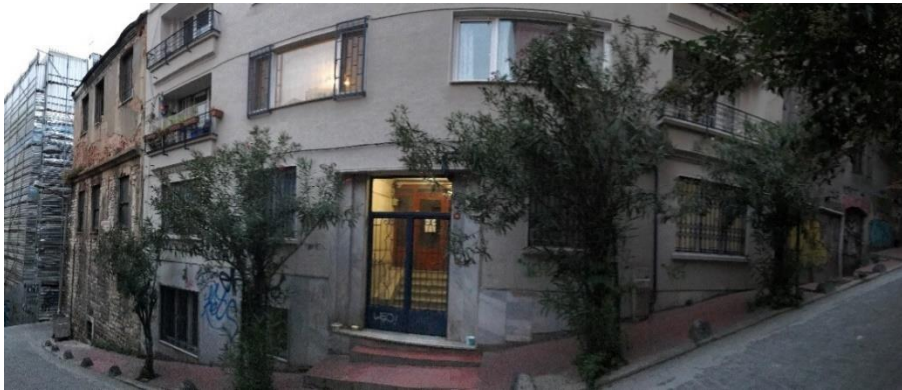
Şekil 4.31 : Galata Kulesi Sokağı üzerinden Rosario Apartmanı cephesi (Güçlü Prifti, 2017).
