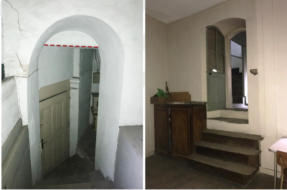
Şekil 5.12 : Solda, zemin kat duvarında açılan geçiş boşluğu. Sağda, galeri katı girişi, ahşap basamaklar (Güçlü Prifti, 2017).
