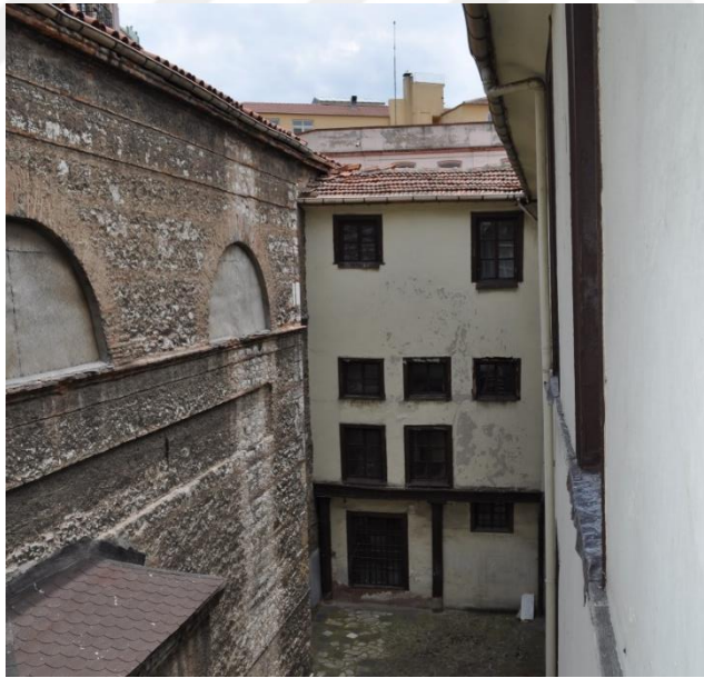
Şekil 4.23 : İkinci avlunun güneydoğusundaki 1 numaralı ek yapı (Güçlü Prifti, 2017).
