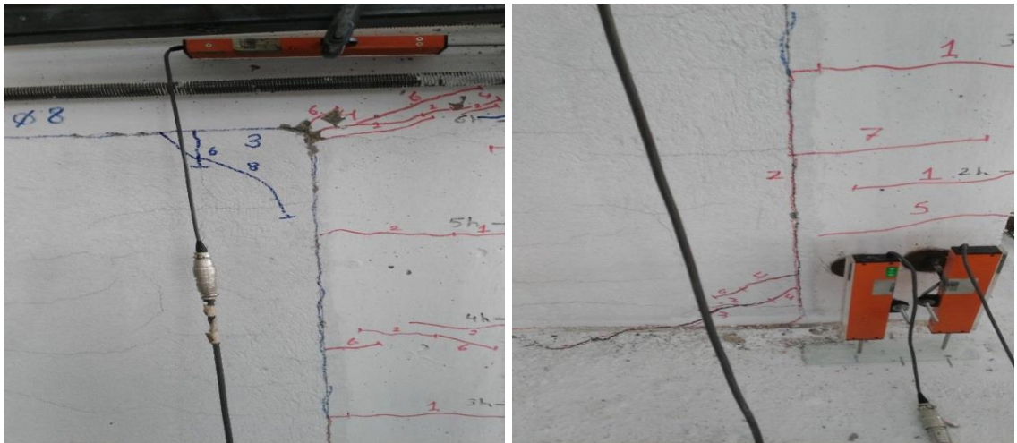
Şekil 4.16. 8. döngü sonunda çatlak durumu
