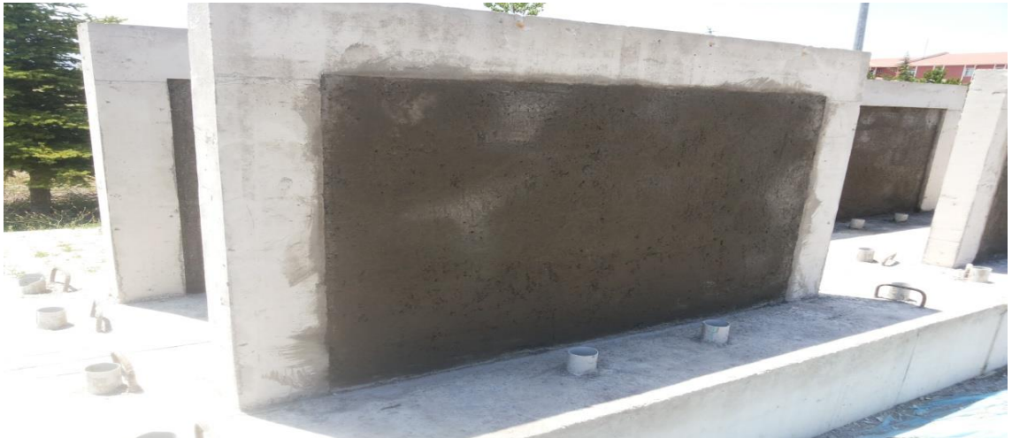
Şekil 3.15. Bölme duvarlara sıva yapılması dış yüz
