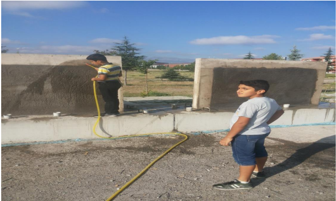
Şekil 3.17. Sıva sulanmış
