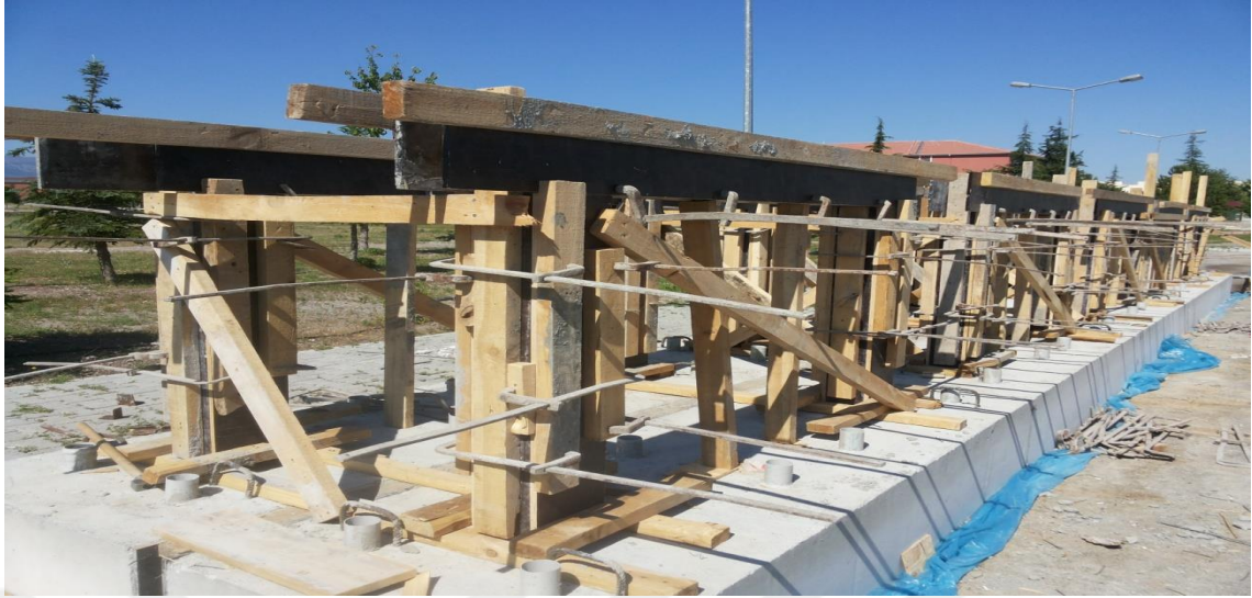
Şekil 3.6. Hazırlanan çerçeve kalıpları
