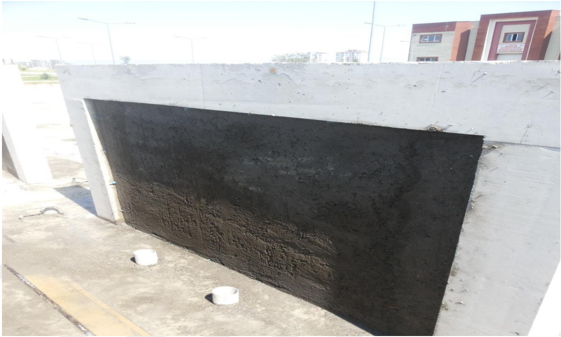
Şekil 3.16. Güçlendirme için çerçevede bırakılan dış
