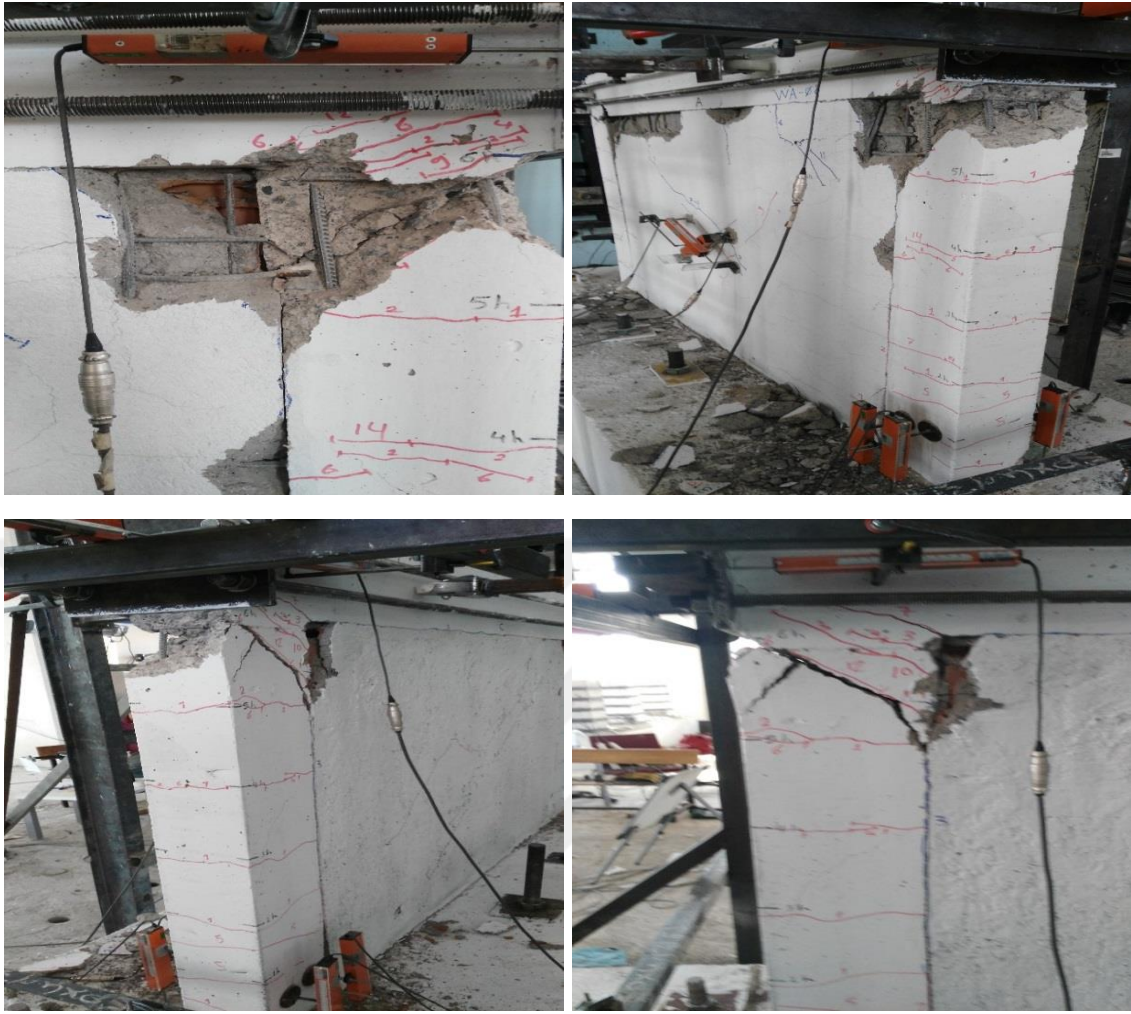
Şekil 4.19. 26, 28 ve 30. döngü sonunda çatlak ve dökülme durumu
