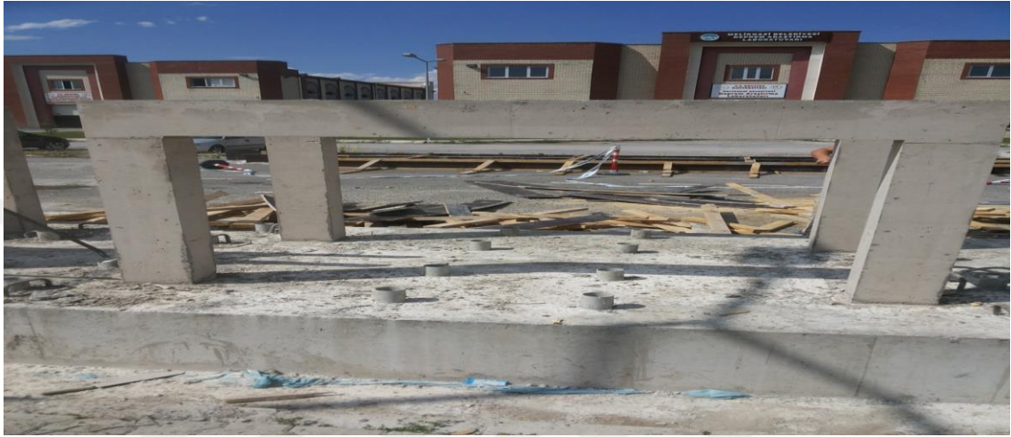
Şekil 3.11. Çerçevelerin kalıplarının sökülüş şekli
