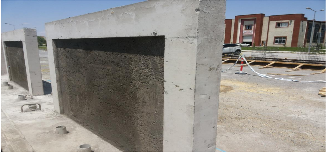
Şekil 3.14. Bölme duvarlara sıva yapılması iç yüz
