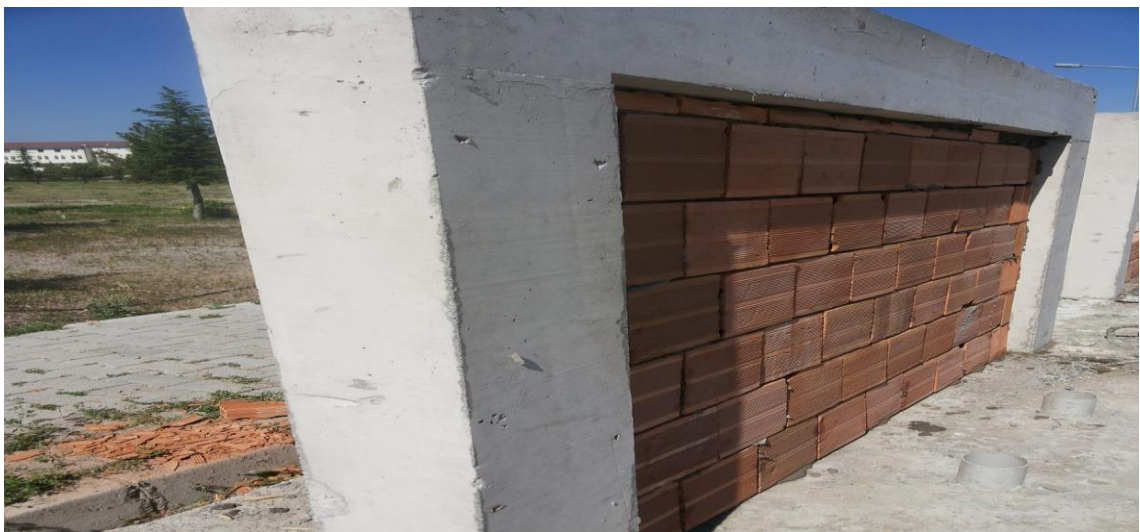
Şekil 3.12. Güçlendirme için çerçevede bırakılan dış
