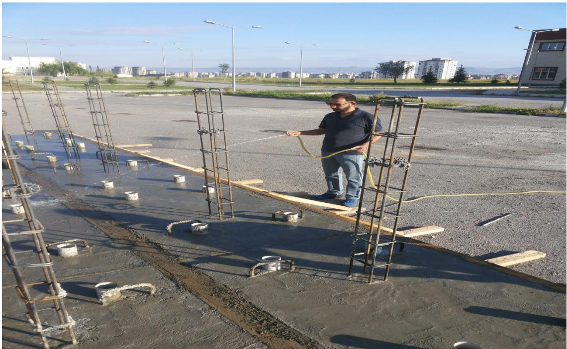
Şekil 3.3. Temel betonu kuru
