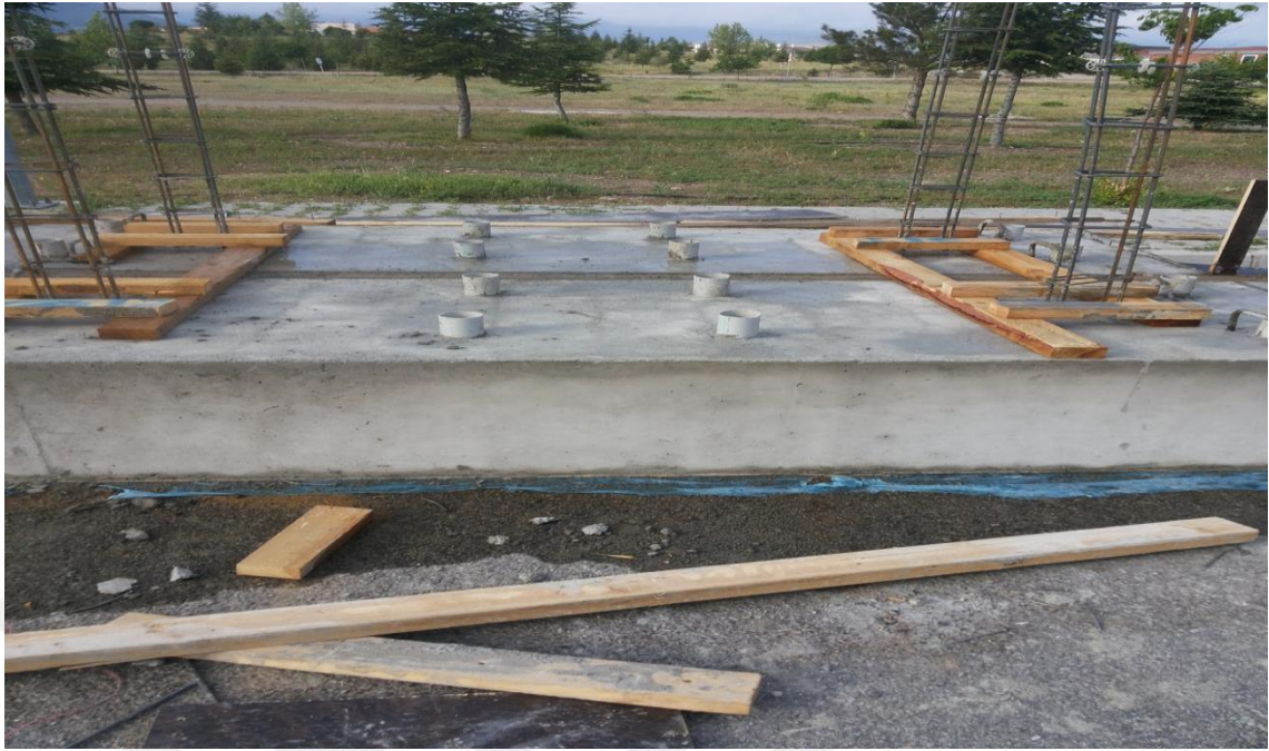
Şekil 3.2. Temel kalıpları sökülümüş
