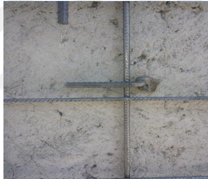
Şekil 3.24. Duvar düzlemine dik ankraj yapımı
