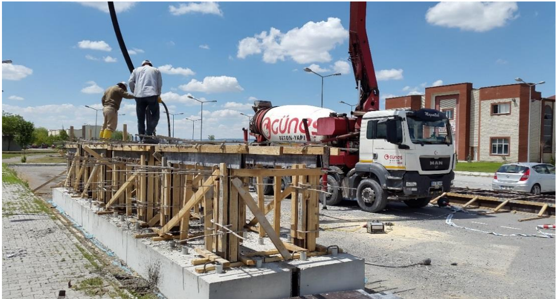
Şekil 3.7. Çerçeve betonlarının dökümü
