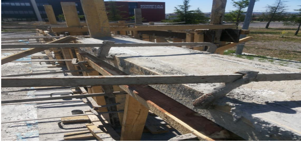
Şekil 3.8. Beton dökümü tamamlanmış çerçeveler
