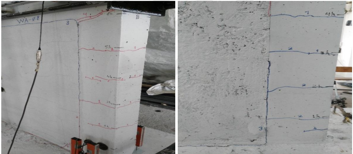
Şekil 4.15 4. döngü sonunda oluşan çatlaklar ve ayrılmalar
