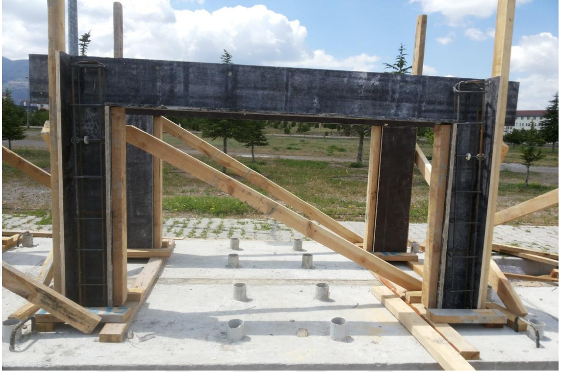
Şekil 3.4. Çerçeve kalıplarının ve donatıların yapımı
