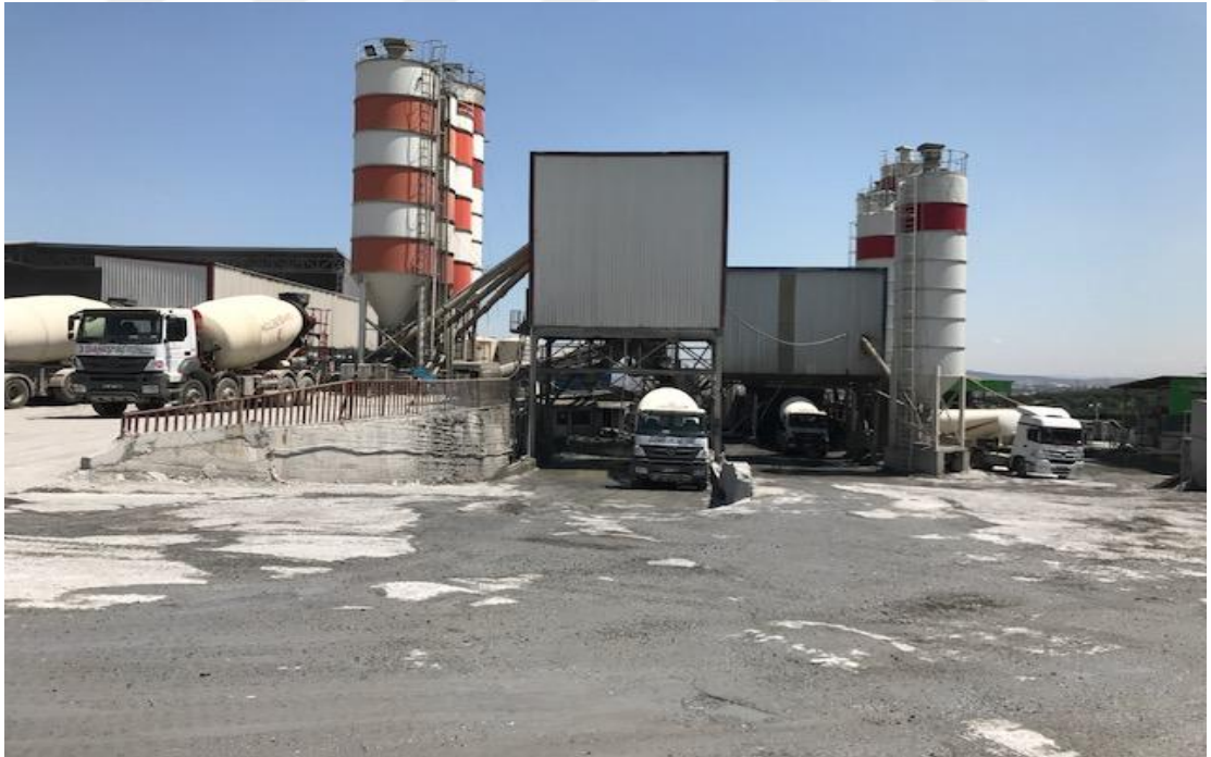
Şekil 3.1: Deneyin yapıldığı beton santrali.
