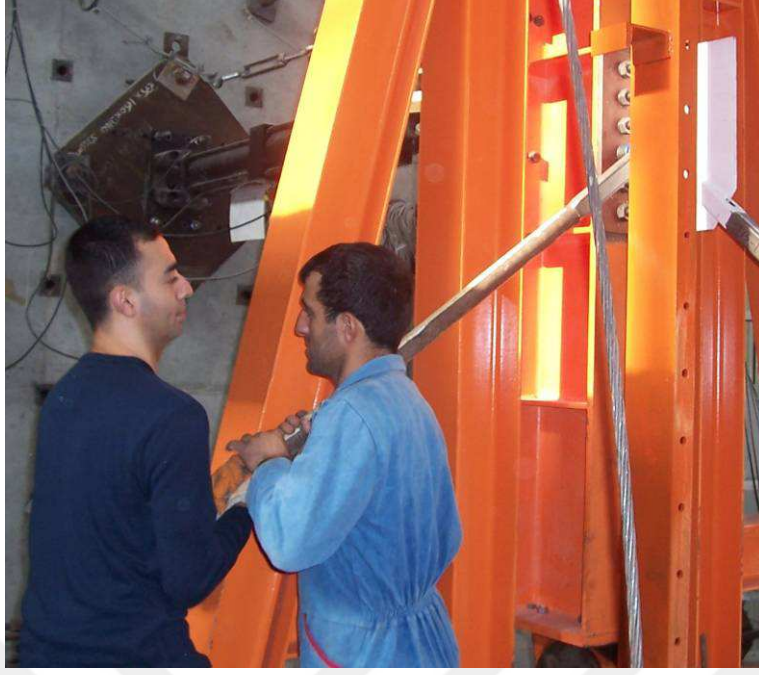
Şekil 3.27 : Bulonlara öngerme verilmesi.
