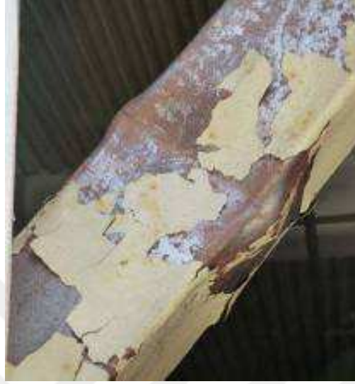
Şekil 2.7 : 2011 Tohoku depremi sonrası çelik çaprazda yerel burkulma ve yırtılma başlangıcı (Midorikawa ve Okazaki, 2012).
