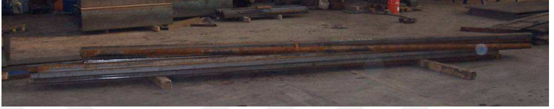
Şekil 3.14 : 6m boyundaki profillerin atölyede durumu.
