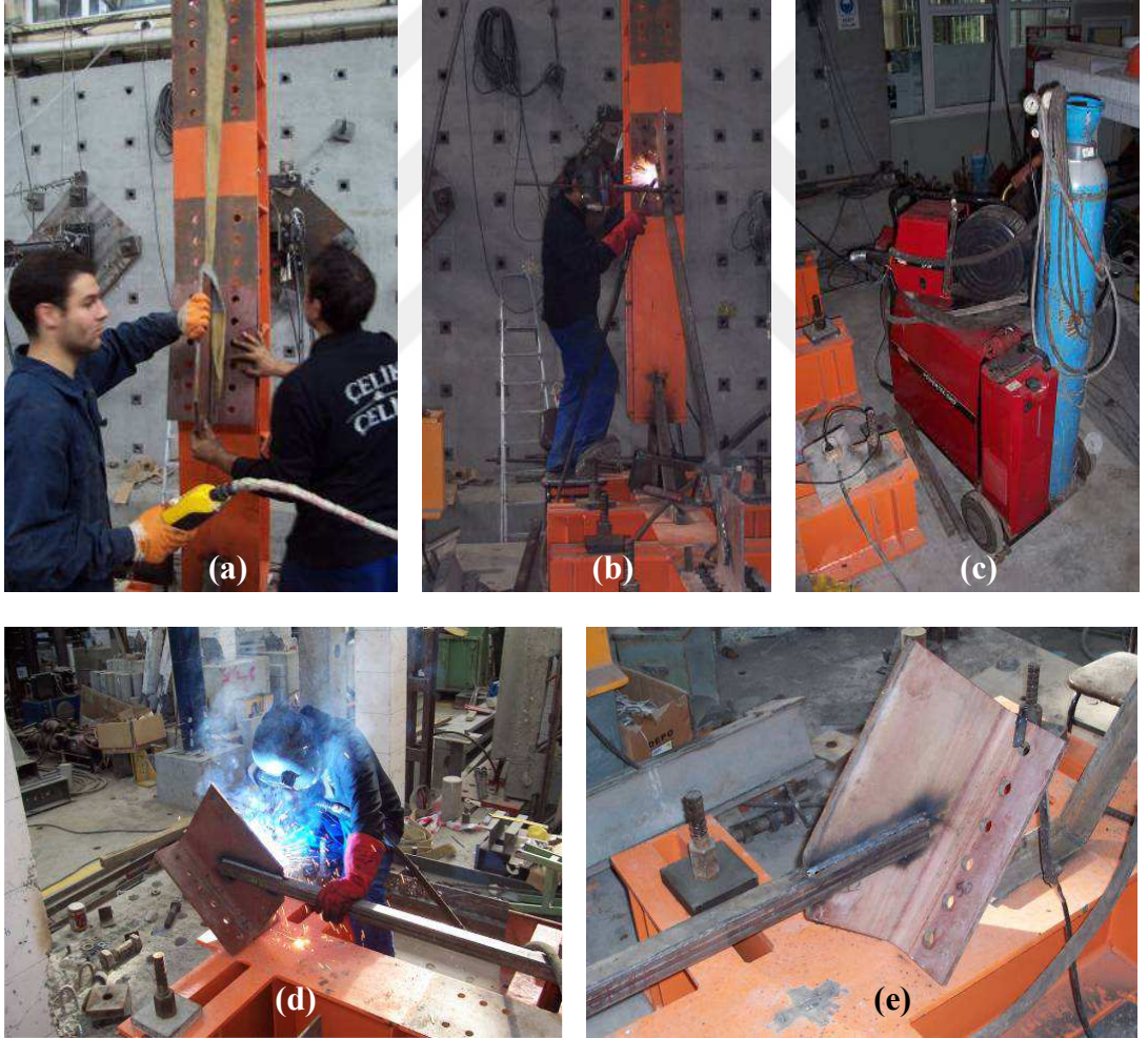
Şekil 3.29 : Numunelerin montajı: (a) Bayrak levhalarının montajı. (b) Yerinde punto kaynak yapılması. (c) Gazaltı kaynak makinesi. (d) Yerde kaynakların yapılması. (e) Tamamlanmış kaynak.
