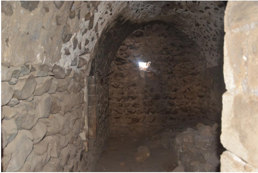
Resim 24: Mor Kuryakos Manastırı'ndaki 8 nolu odanın dıştan ve içten görünümü.
