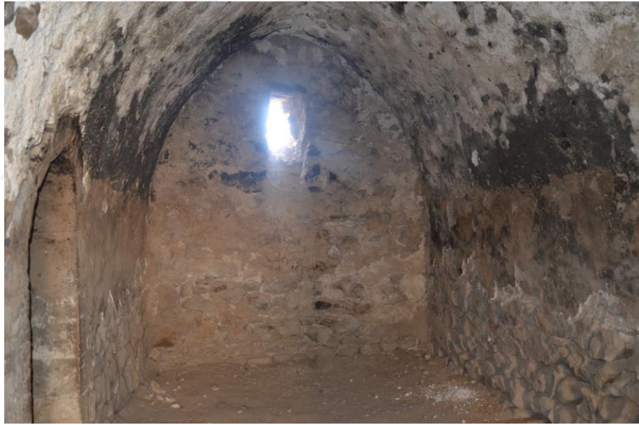
Resim 21: Mor Kuryakos Manastırı'ndaki 5 nolu odanın dıştan ve içten görünümü.
