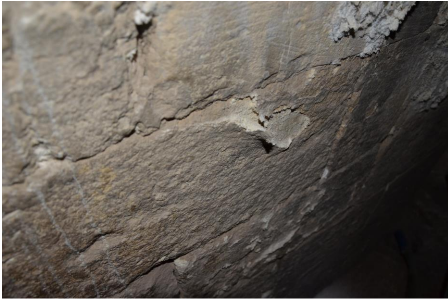
Resim 43: Mor Kuryakos manastır mezar odasının duvar örgüsündeki suyun hareketi.
