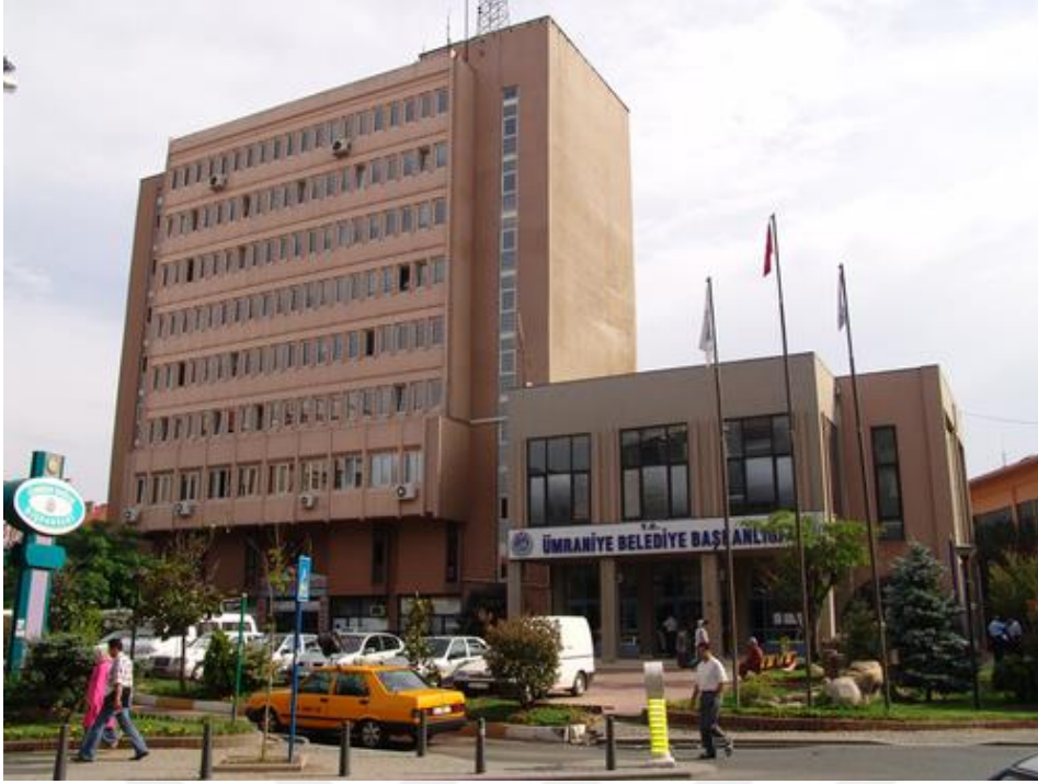
Şekil 3.1: Bina genel görünümü.
