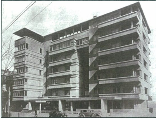
Şekil 43. Üçler Apartmanı, İstanbul Kaynak: Arkitekt, 1935, sayı:5, s. 129
