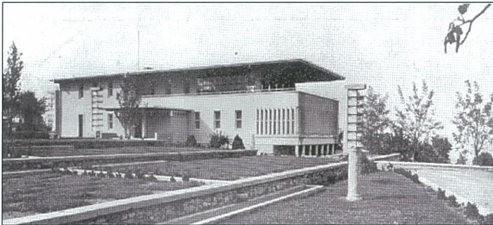
Şekil 32. Hariciye Köşkü, güneyden görünüş, Ankara Kaynak: Arkitekt, 1935, sayı:11-12, s. 311
