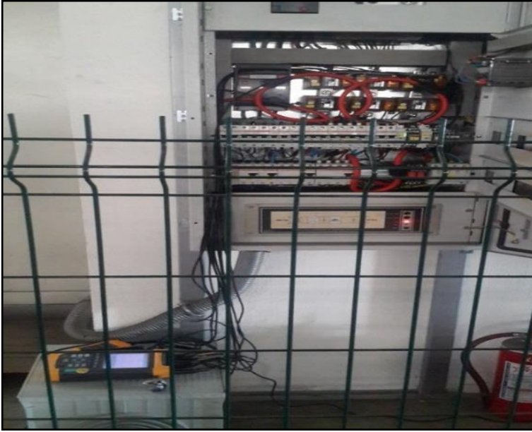
Şekil 3.4 Fluke 435 analizörün bağlantı şekli.
