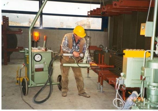
Şekil 3.2. Öngerilme işleminin yapılması ( http://www.paul.eu/en/produkte/spannbeton-technik/bauteilfertigung.html )
