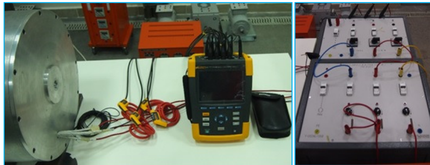
Şekil 6.22. Generatör yükleme ünitesi ile ölçme elemanları.
