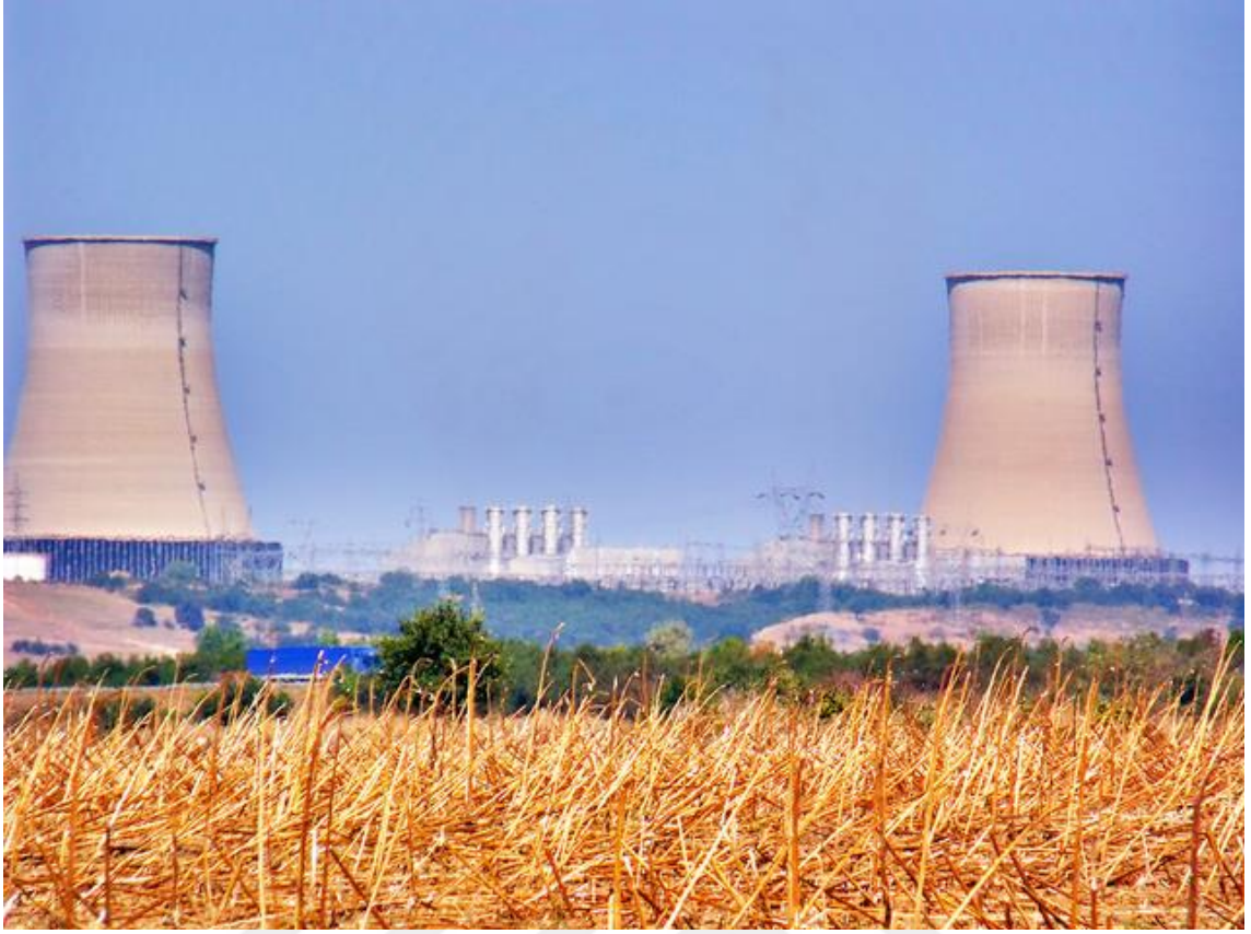
Şekil 8.6 Hamitabat soğutma kuleleri[22]
