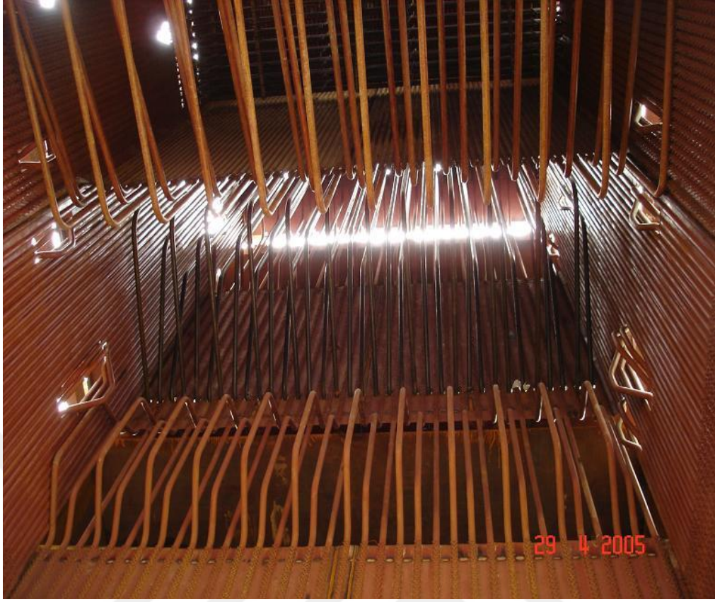
Şekil 5.3 Su borulu kazanların içten görünüşü [23]
