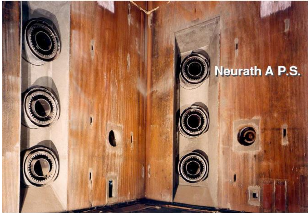
Şekil 5.4 Su borulu kazanlardaki yakıcı ağızlar [23]
