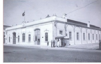
Şekil 16. Fransız Gümrük Binası Ön Cephesi Kaynak: http://ege.gtb.gov.tr/kurumsal/izmir-gumrukleri-tarihcesi
