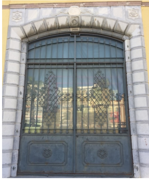
Şekil 22. Fransız Gümrük Binası Ön Cephe Kapısı Kaynak: G. Büke Doğru'nun Kişisel Arşivinden Alınmıştır.
