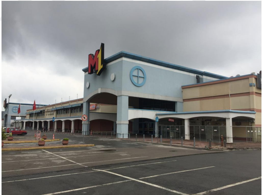
Şekil 4.36. Zamanla Tahrip Olmuş Cephe
