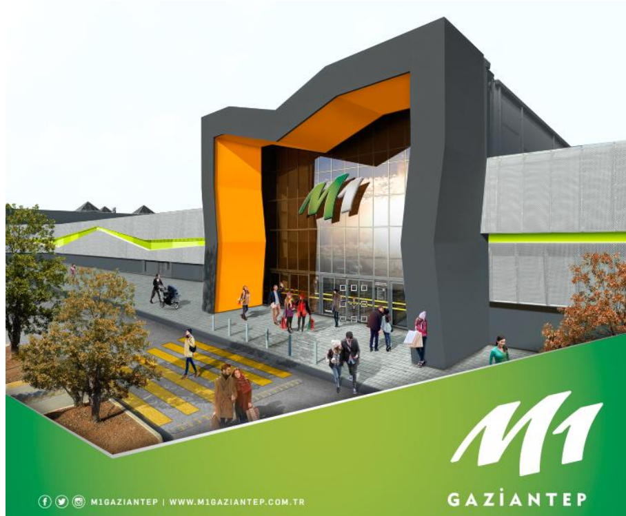
Şekil 4.8. M1 Gaziantep Avm Cephe Yenilemesi
