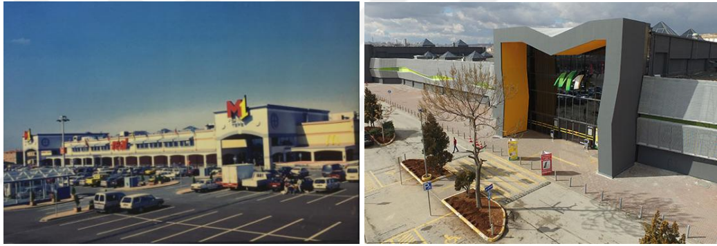
Şekil 4.16: M1 Gaziantep Avm Cephe Yenilemesi Öncesi ve Sonrası
