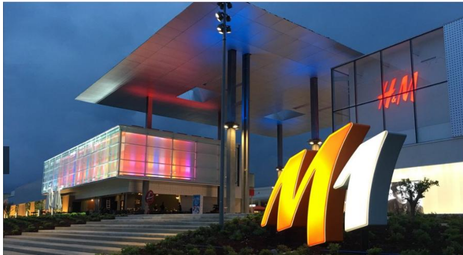
Şekil 4.60. M1 Adana Avm Cephesi Yeni Hali
