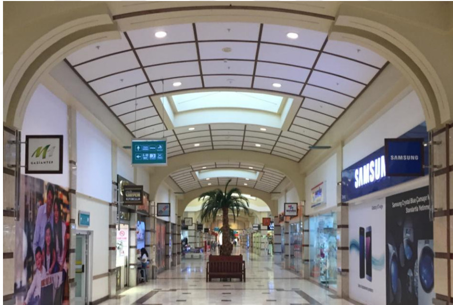
Şekil 4.12. Sirkülasyon Alanı Üzerinde Kullanılan Doğal Aydınlatma Elemanları
