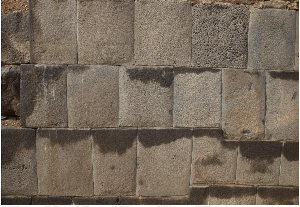
Fotoğraf 58: Ön Yüzü Bombeli Taş Bloklardan Yapılmış Duvar/Ayanis
