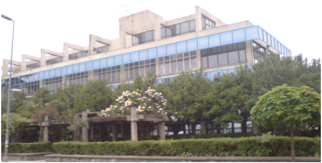
Şekil 3.9 : Beykoz Paşabahçe Şişecam Fabrikası, yıkımından önce (Erşahin, 2017).
