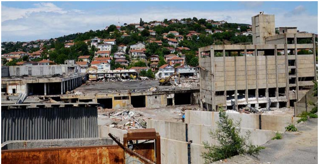
Şekil 3.10 : Beykoz Paşabahçe Şişecam Fabrikası, yıkımından sonra (Erşahin, 2017).
