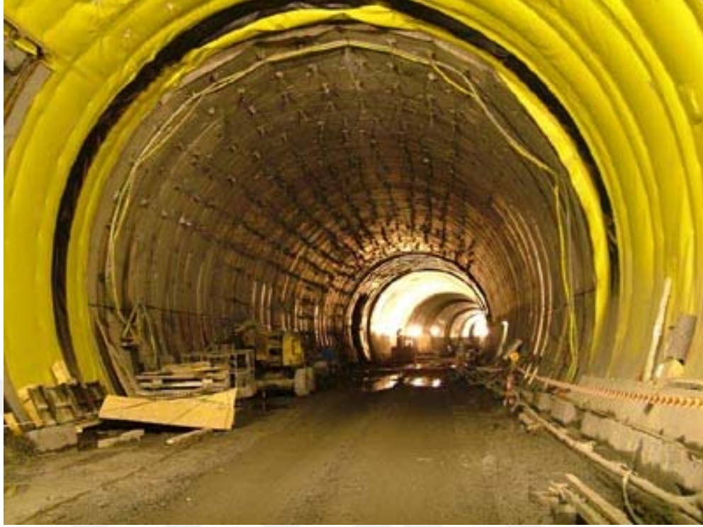
Şekil 2.11 : Tünelde geomembran uygulaması
