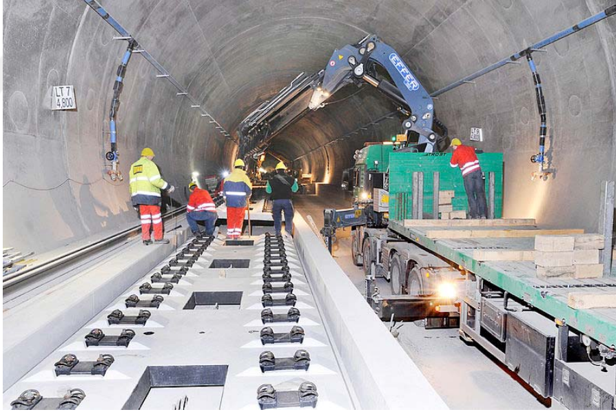
Şekil 3.4 : ÖBB-Porr balastsız hat serilimi [16]
