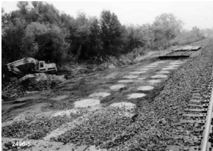
Şekil 5.11 : Taş kolonların yaklaşım bölgesine yerleşimi [31]
