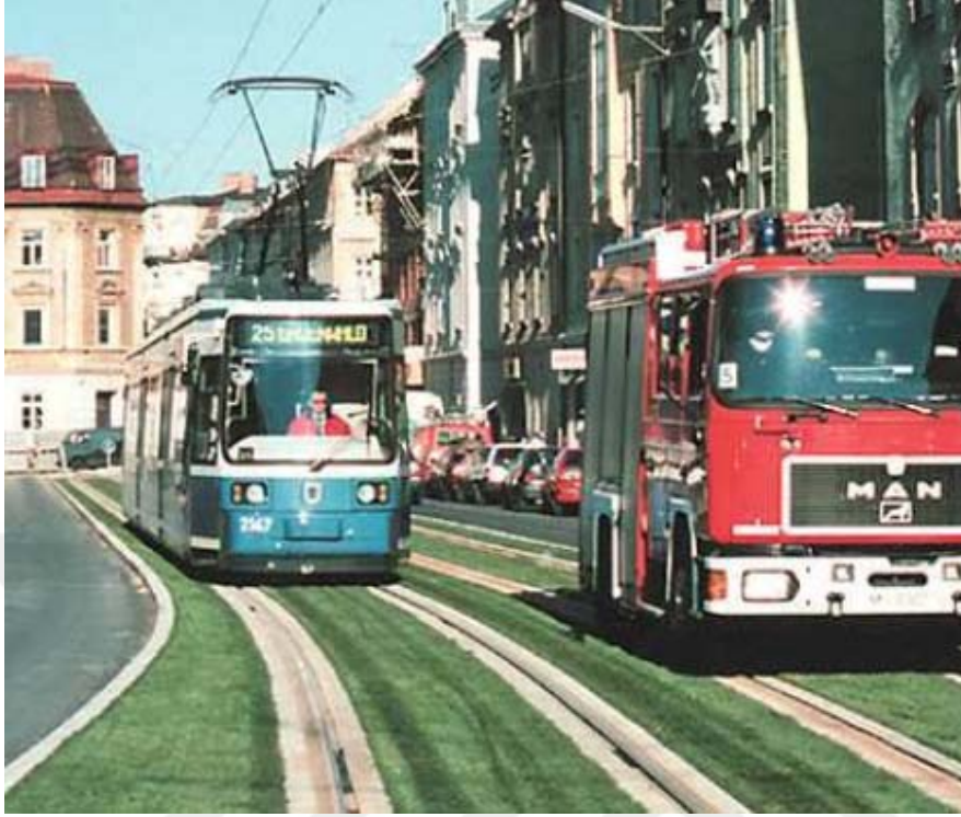
Şekil 3.5 : Edilon gömülü ray sistemi [2]
