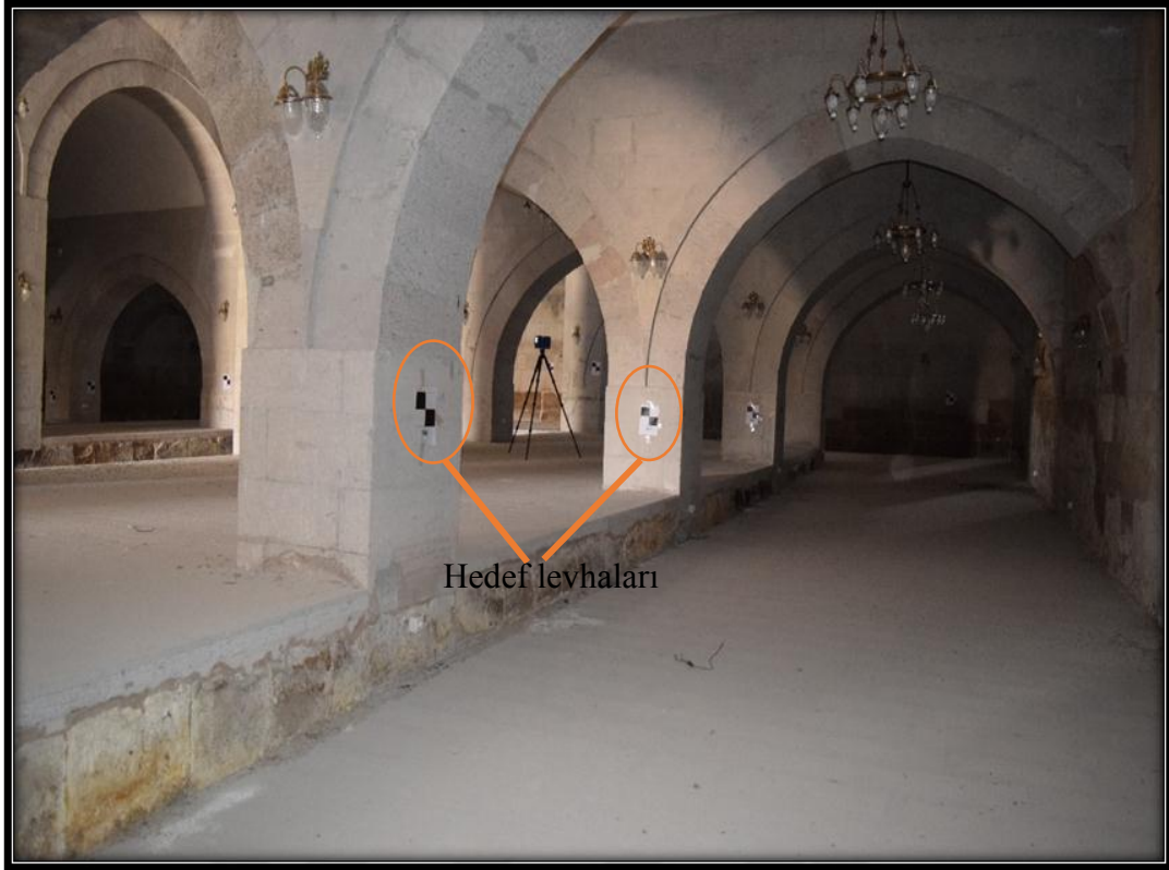
Şekil 4.6. Kâğıt Hedeflerin duvarlara yapıştırılması ve yersel lazer tarama işlemi
