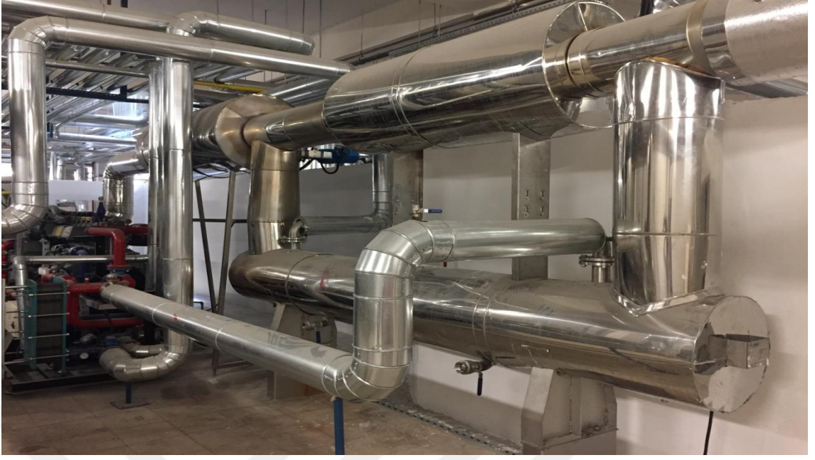
Şekil 3.13 Hastanede tesis edilen 275 kW gücündeki egzoz eşanjörü.
