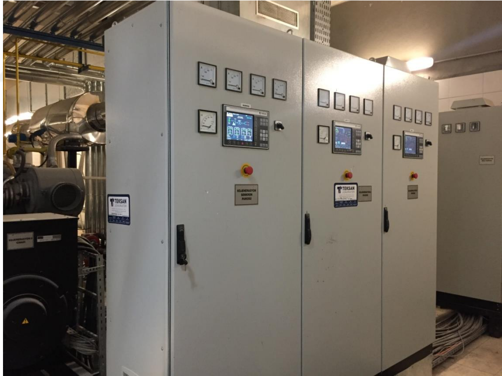
Şekil 3.19 Trijeneratör santrali kumanda panoları.
