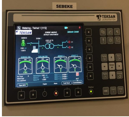
Şekil 3.21 Comap marka IntelliVision8 model dijital kontrol ekranı.
