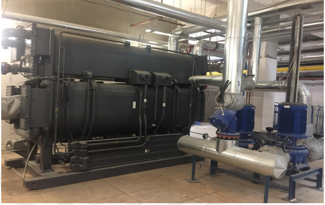
Şekil 3.15 Hastaneden kullanılan 675 kW gücündeki Absorbsiyonlu soğutucu
