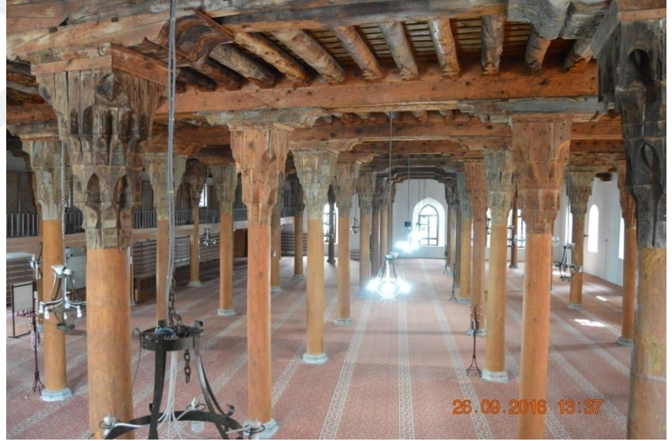
Ulu Camii'nin İç Mekânı
