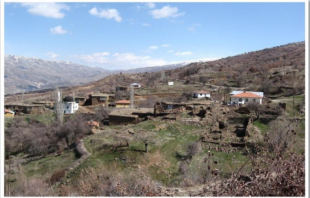
Foto 17: Depremden Zarar Görmüş Meskenlerin Yanında İnşa Edilen Yeni Konutlar (Mezraa Köyü)
