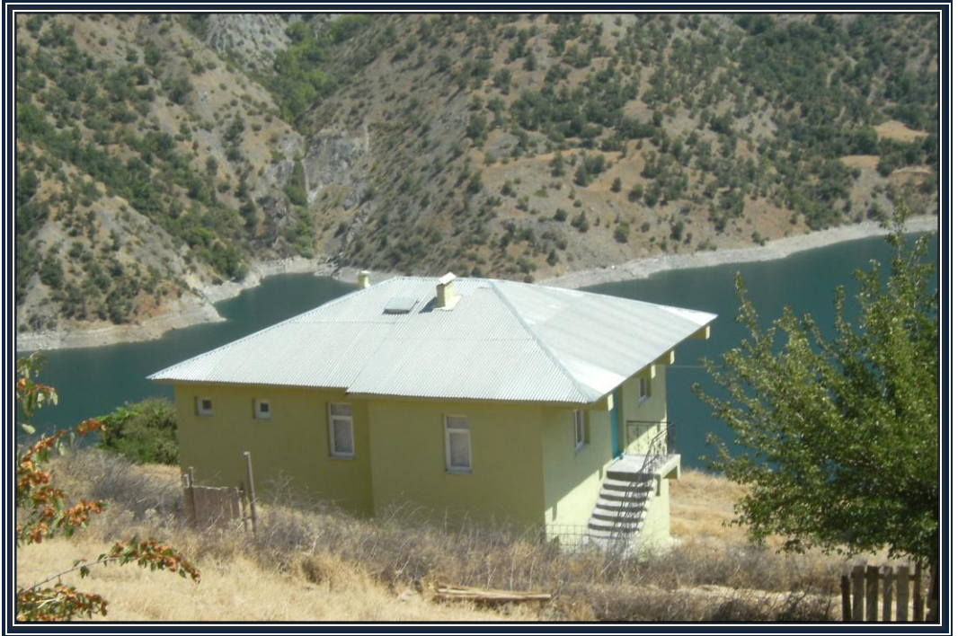
Foto 22: Sac Örtülü Kıрма Çatı Sistemine Sahip Yeni Konut (Ulutaş Köyü)
