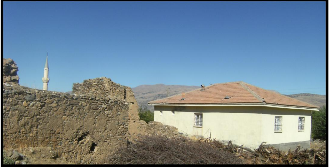
Foto 18: Araştırma Sahasındaki Depremden Zarar Görmüş Eski Mesken ve Devlet Desteğiyle İnşa Edilmiş “Tek Katlı” Yeni Mesken Tipi (Damlı Köyü)
