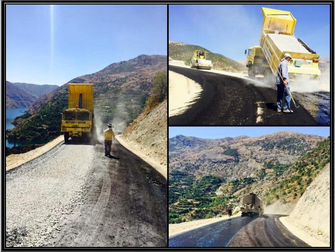
Foto 39: Behramlı-Konurtay grup köy yolu genişletme ve asfaltlama çalışmaları
