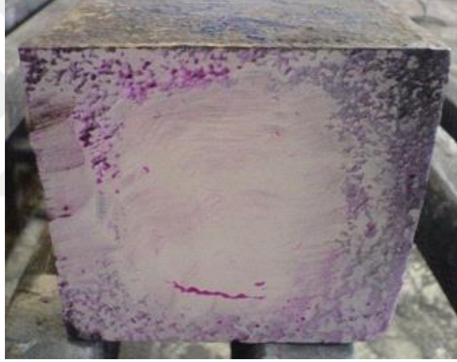
Şekil 4.12. Sıvı penetrant testi sonrasında ortaya çıkan çatlaklar
