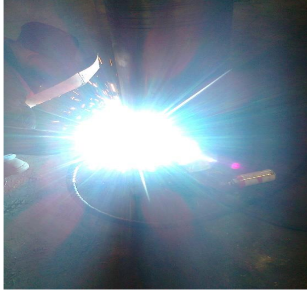
Şekil 3.19. Numunelere dolgu kaynağı uygulanması
