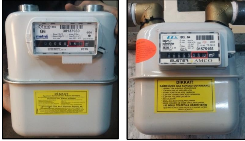
Şekil 4.13 G6 ve G4 model körüklü gaz sayaçlarının genel görünüşleri.
