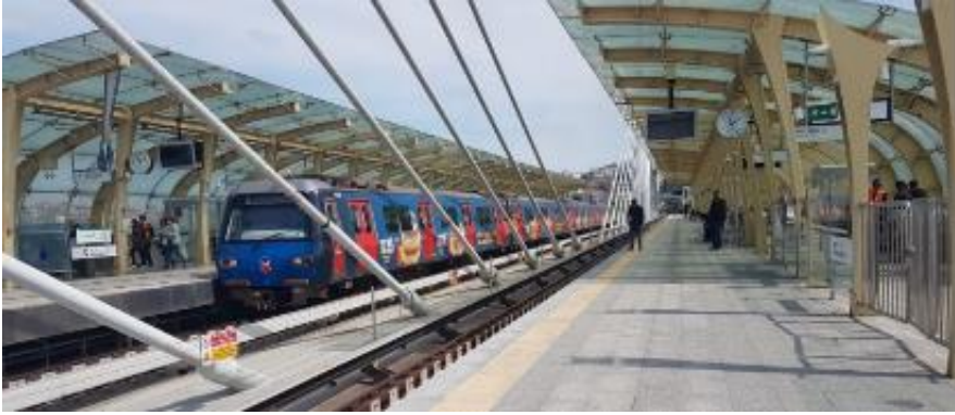
Şekil 2.19 : Haliç metro istasyonu peron katı
