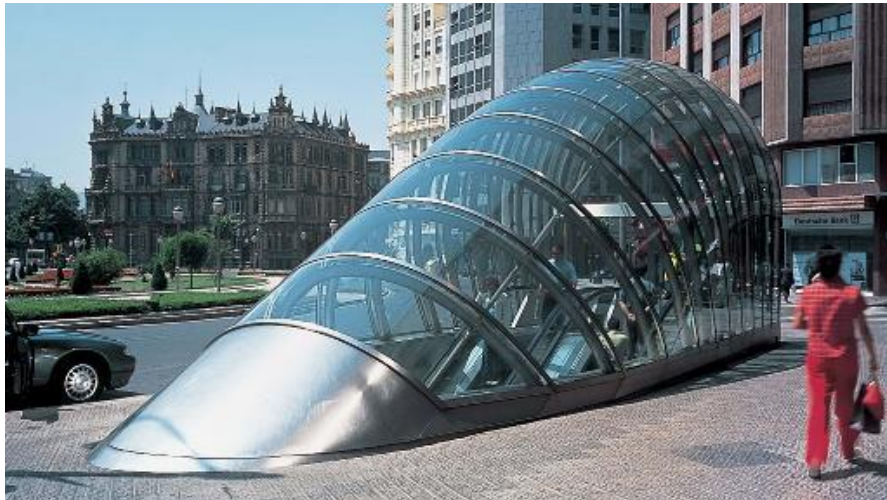
Şekil 2.22 : Bilbao metro istasyonu girişi (Url1.16, 2017).
