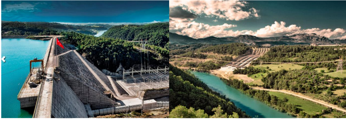
Şekil 3.7. Adana Yedigöze Sani Bey Barajı ve HES (Anonim, 2017d).
