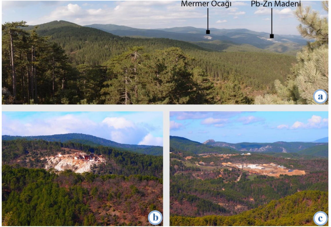
Şekil 4.9 Çalışma sahasında bulunan maden işletmeleri
