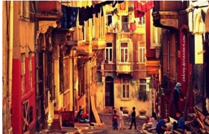
Şekil 3.2. İstanbul Tarlabası dönüşüm alanında yıpranmış ve rehabilite edilmeye ihtiyaç duyan tarihi bir yerleşim alanı.
