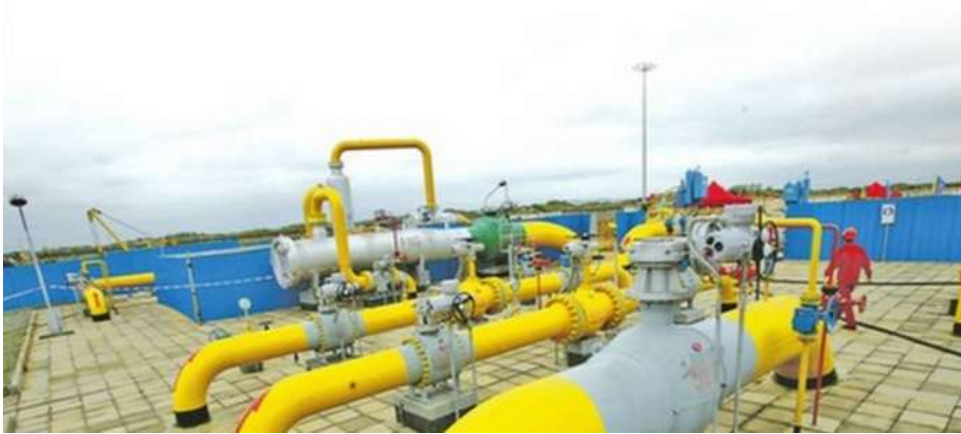
Şekil 2.1. Vanaların Boru hatlarındaki montajlı durumu
