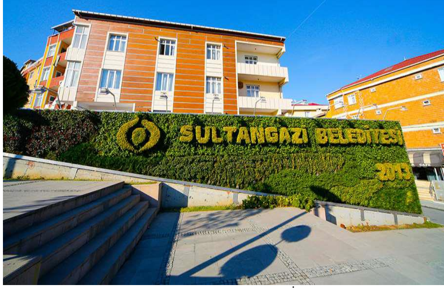
Şekil 2.7. Peyzaj duvarları-Sultangazi Belediyesi-İstanbul (Anonim, 2013)
