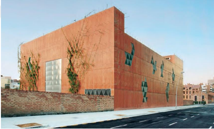
Şekil 2.4. Izgara sistemi-Elektrik Trafo Merkezi-İspanya (Helzel, 2012)
