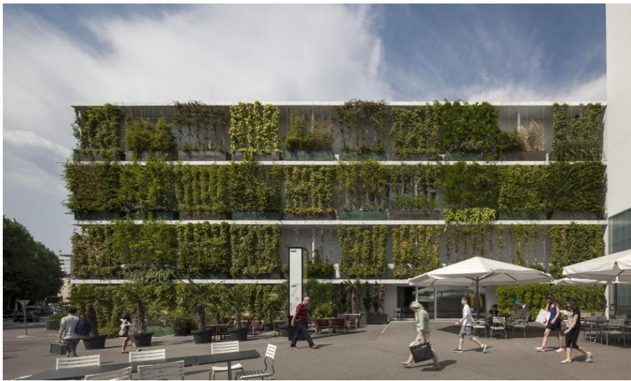
Şekil 2.5. Tel Ağ sistemi-Basel Stücker Alışveriş Merkezi-Almanya (Anonymous, 2017h)
