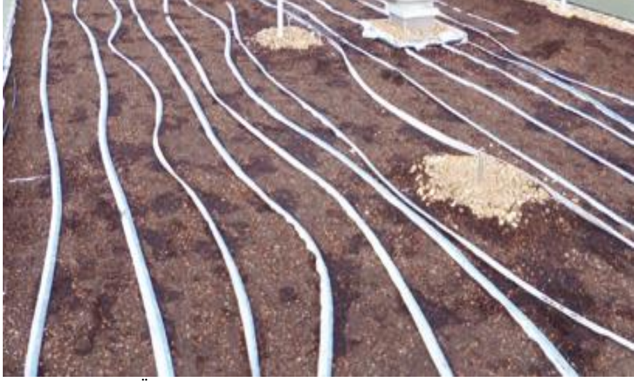
Şekil 2.60. Minifie Erken Öğrenme Merkezi yeşil çatısında sulama borusunun döşenmesi-Melbourne (Anonymous, 2014)
