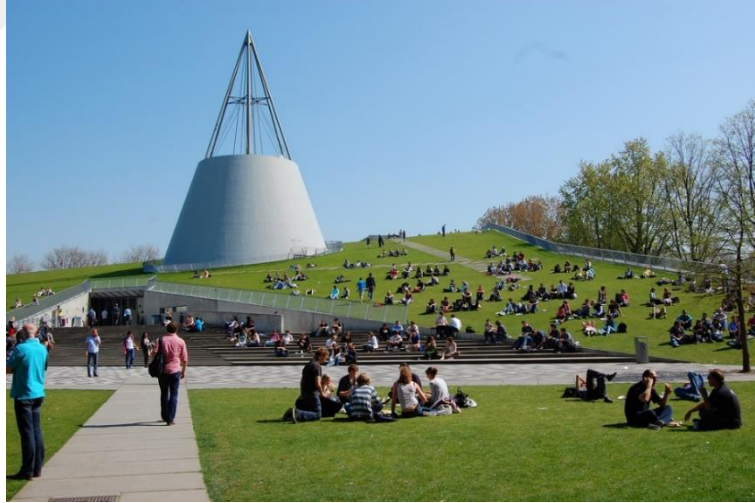
Şekil 2.56. Dolaşım saęlanan yeşil çatı uygulaması-Tu Delft Kütüphanesi-Hollanda (Anonymous, 2011b)
