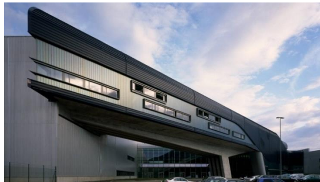
Şekil 3.32 BMW Merkez Binası, 2005, Leipzig - Almanya 56
