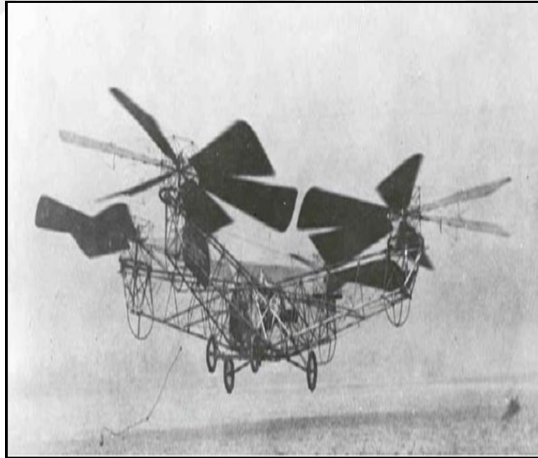
Şekil 2.1. Bothezat tarafından geliştirilen dört rotorlu hava aracı.
