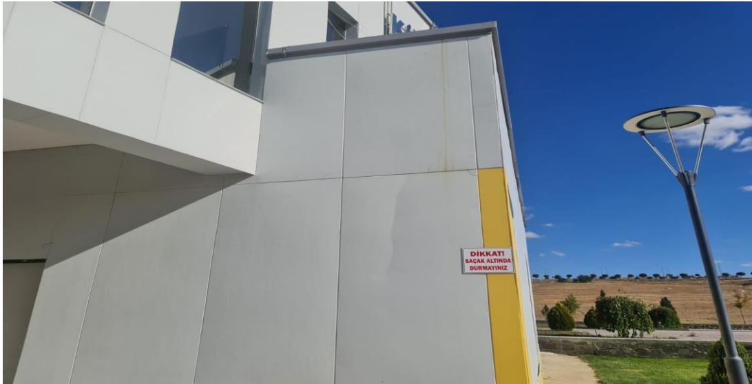
Şekil 4.15: ÇAKÜ Kütüphanesi Uyarı İşareti
