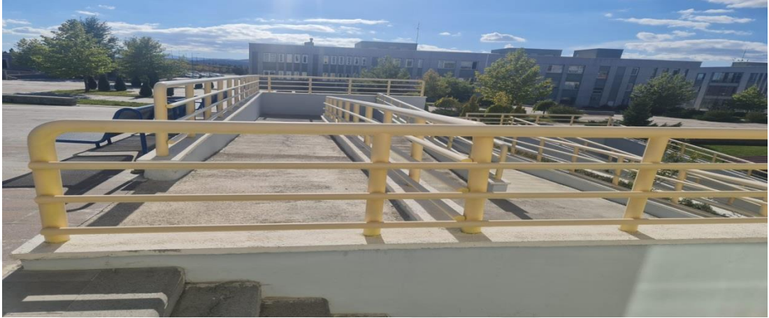
Şekil 4.7: ÇAKÜ Kütüphanesi Engelli Rampası
