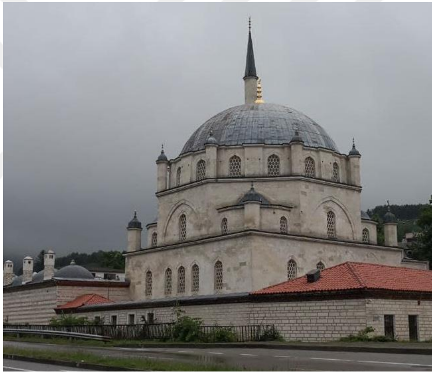
Resim 1.5. Şumnu Şerif Halil Paşa Camii genel görünüm.
