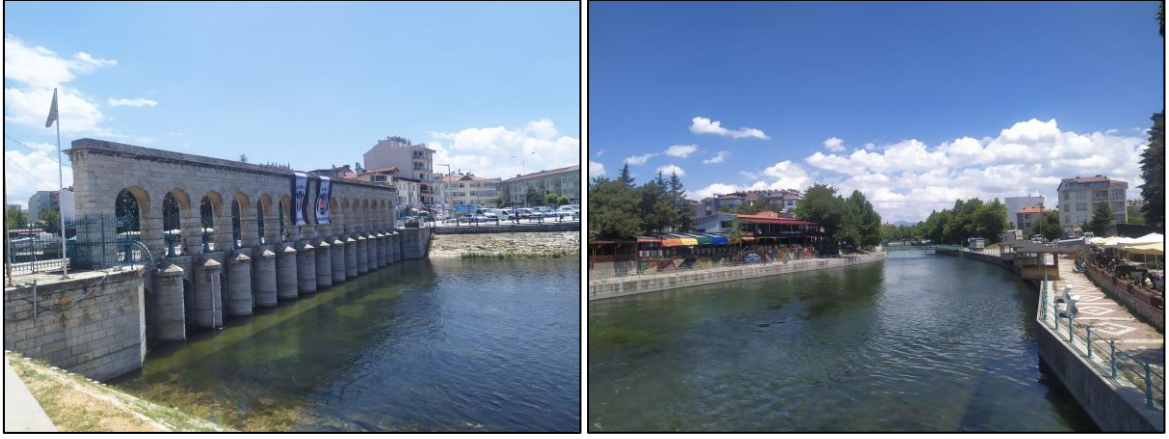
Şekil 18. Beyşehir regülatörü ve kanalı (Haziran, 2021)
