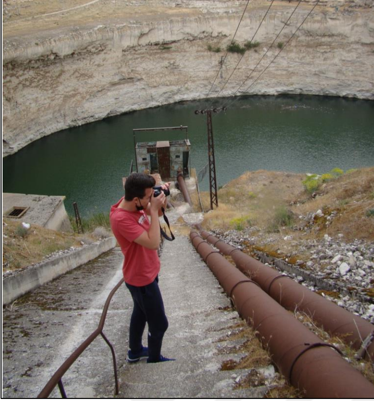
Şekil 25. Obruk çevresindeki tarlalarda sulama yapmak için gölden çekilen suların tarlalara taşındığı borular (Haziran 2021)
