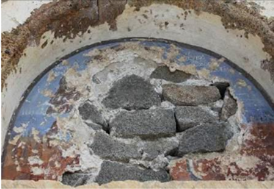
Görsel 32. Kıpçılar Mahallesi Kilisesi, Giriş Lentosu Üzerinde Yer Alan Aziz Teodoros Tasviri Kalıntısı (Okuyucu,2013, s.773)
