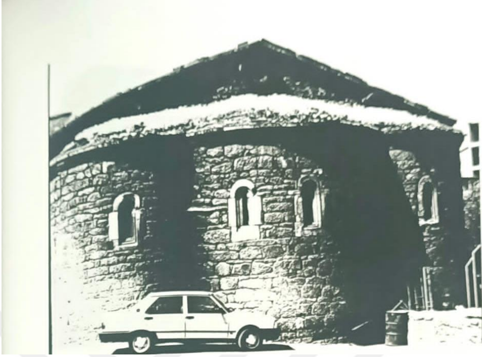
Görsel 21. Doğu Cephesi Genel Görünüşü (Haldun Özkan)
