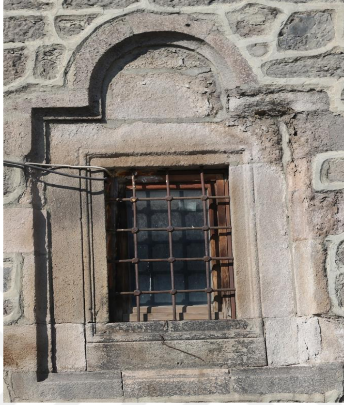
Görsel 23. Güney Cephe, Batıdan Birinci Sıradaki Pencere
