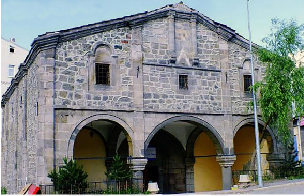
Görsel 15. Batı Cephe Genel Görünüşü
