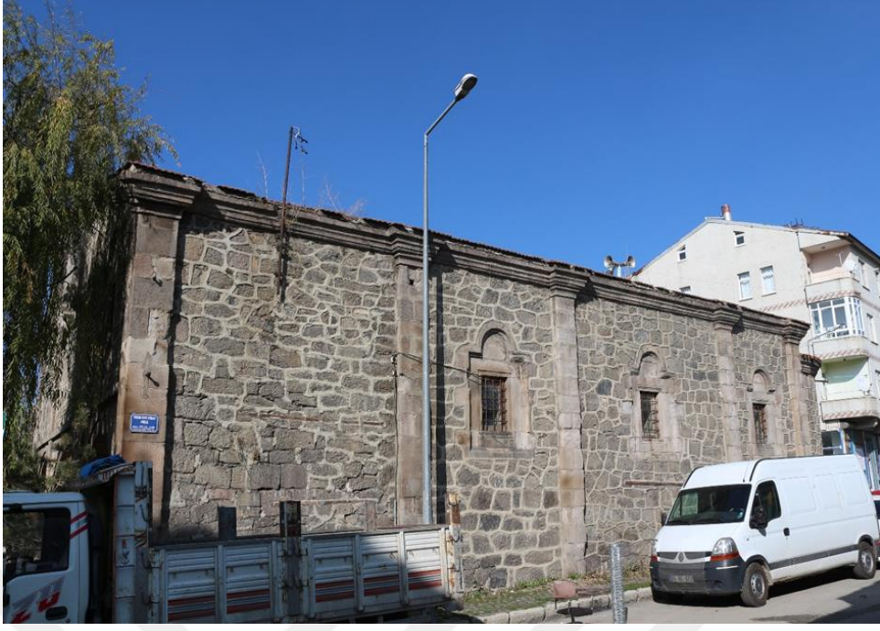
Görsel 17. Güney Cephe Genel Görünüşü
