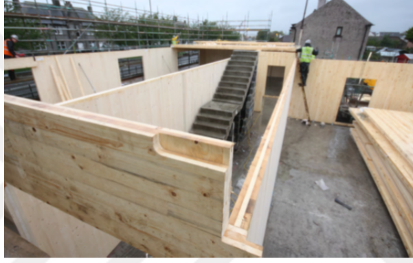
Şekil Ek 1.2: Yapı Örneği 1'in yapım aşamalarına ait görseller.
