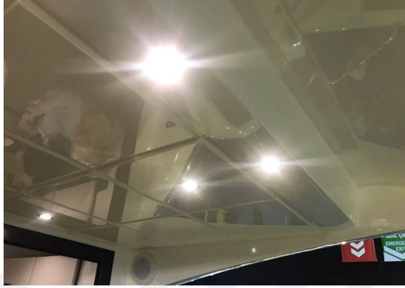
Şekil 299: Prestige 460, Dış Mekân Aydınlatma Detay
