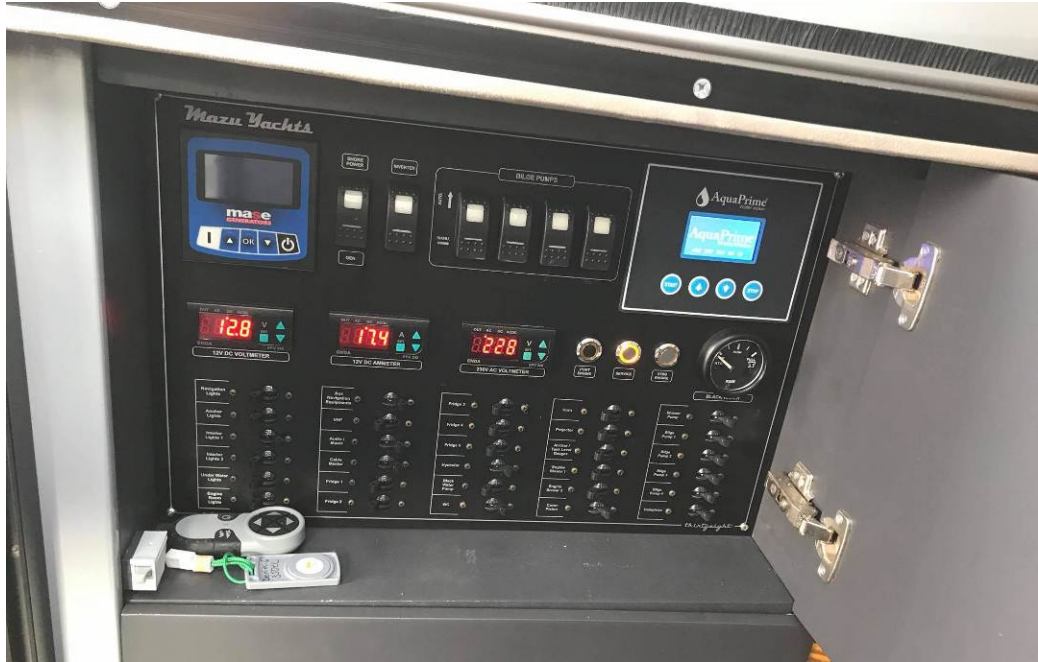
Şekil 170: Mazu Yachts 82, Elektrik Panosu
