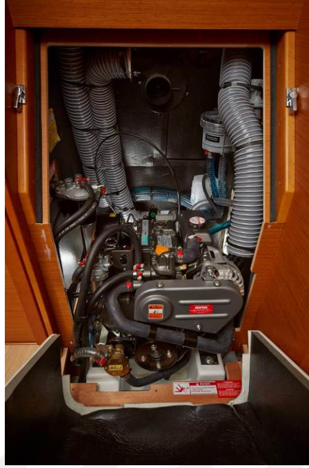
Şekil 98: Sun Odyssey 349, Yelkenli, 10,34 metre, Motor Bölümü
