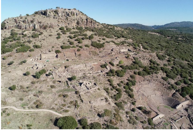
Şekil 3. Assos kentinin güney yamacında bulunan yapılar
