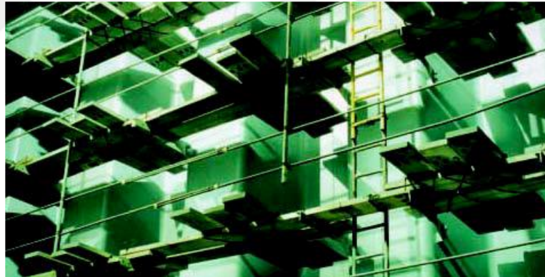
Şekil 8.1: Tank içi ızgaralı merdiven (Url-9).
