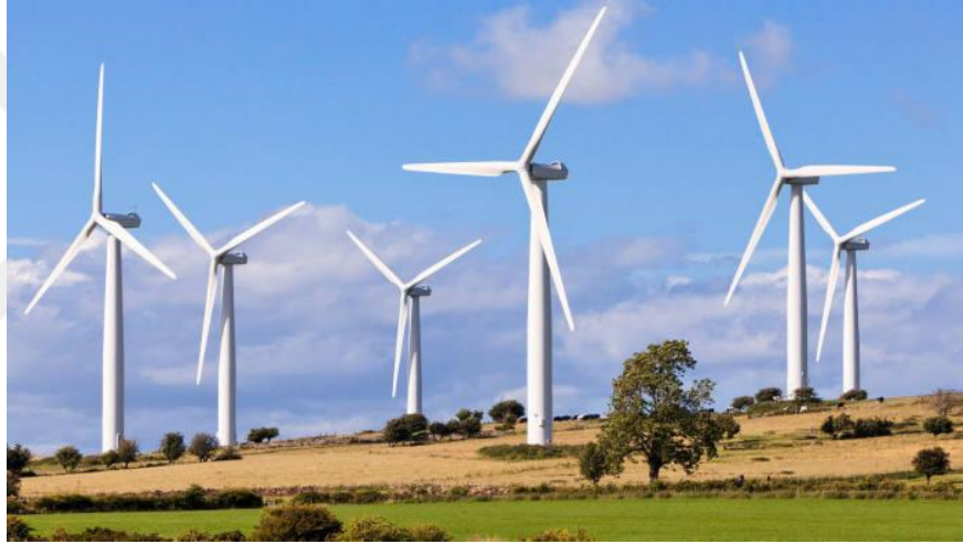
Şekil 1.5. Yatay eksenli rüzgâr türbinleri
