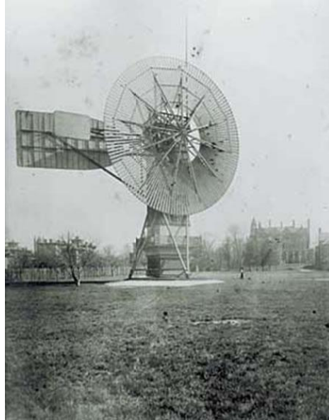
Şekil 1.2. Charles F. Brush tarafından tasarlanan ve ilk elektrik üretimi yapan rüzgâr türbini [11]
