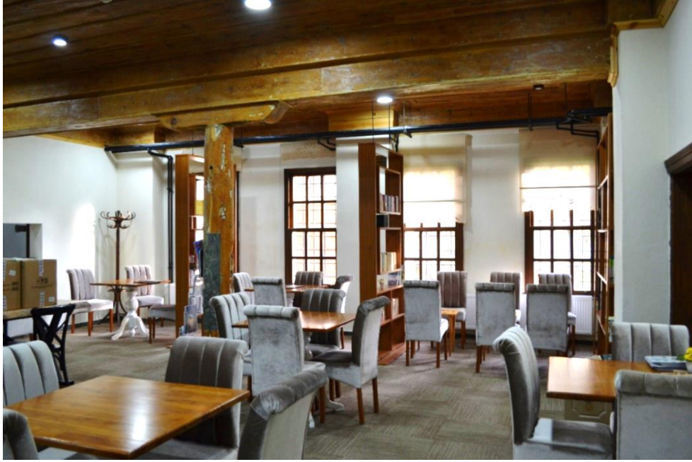
Görsel 4.30. Talas Amerikan Erkek Okulu Yemekhane Ahşap Taşıyıcı ve Tavan Döşemesi (Suvay, 2021)
