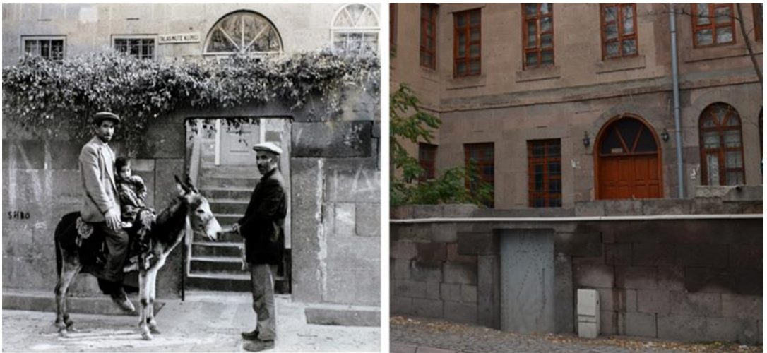
Görsel 4.14. Talas Kız Okulu Yerleşkesi Dispanser Ek Yapı Batı Girişi Dönüşümü (SALT Research; Suvay, 2021)
