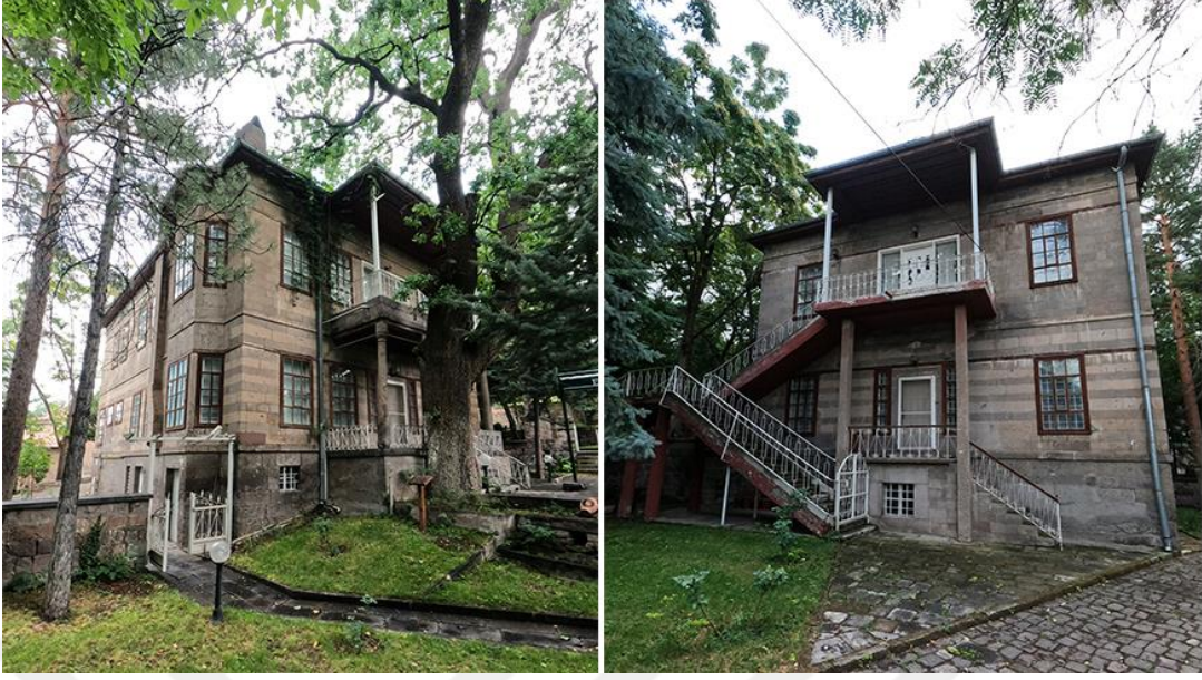
Görsel 4.19. Talas Amerikan Kız Okulu Yerleşkesi Misyoner Lojmanı (D) Güney ve Kuzey Cephesi (Suvay, 2021)
