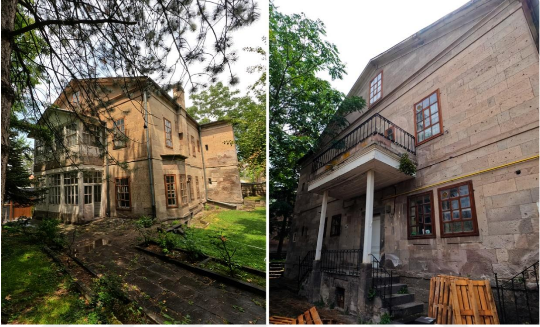
Görsel 4.16. Talas Kız Okulu Yerleşkesi Dr. Dodd Evi Güney ve Kuzey Cephesi (Suvay, 2021)
