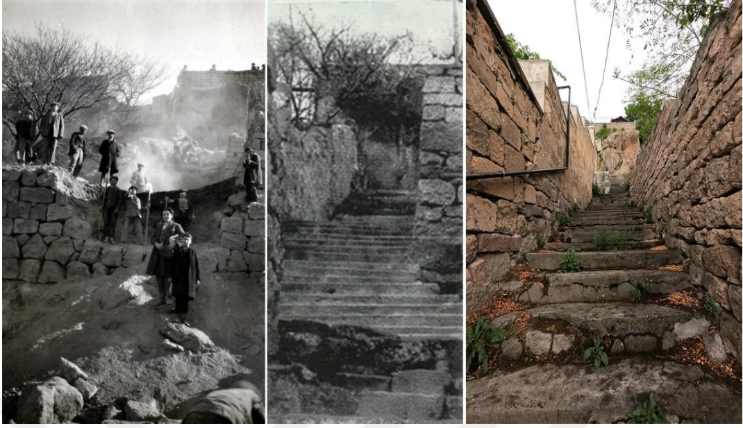
Görsel 4.26. Talas Amerikan Okulu Yerleşkelerini Birbirine Bağlayan Merdiven İnşaatı (SALT Research, 1930; Banner, 1967; Suvay, 2021)
