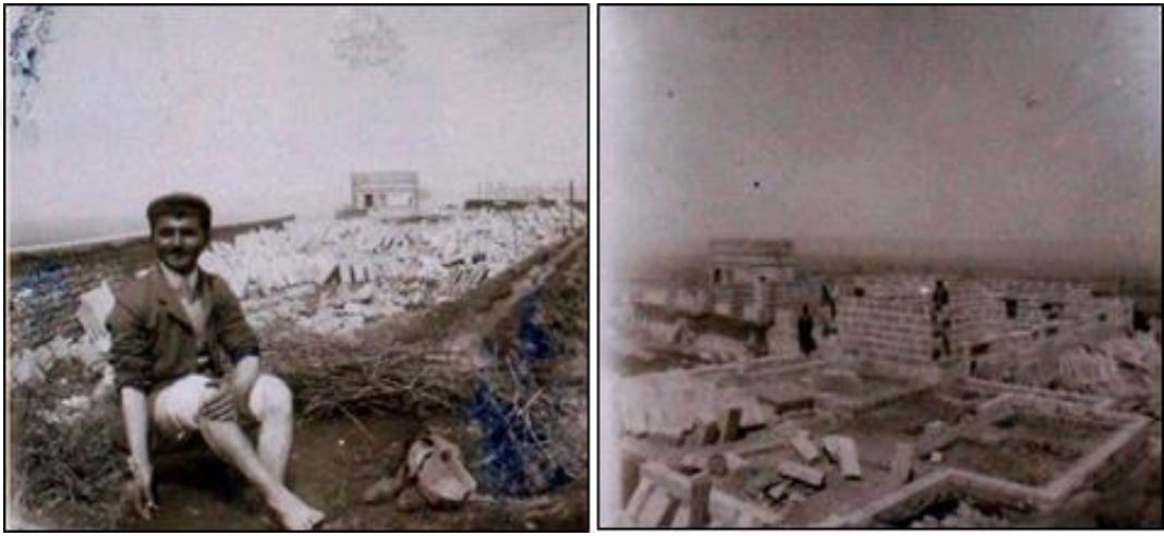
Görsel 4.24. Talas Amerikan Erkek Okulu ve Mr. Wingate' in Evinin İnşaatı (SALT Research, 1906)
