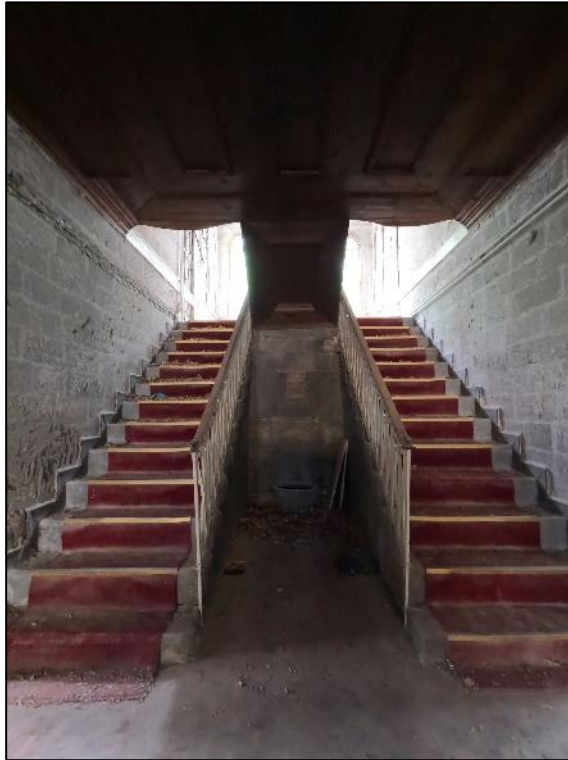
EK-4: Talas Amerikan Kız Okulu Zemin Kat Merdiveni (Suvay, 2021)
