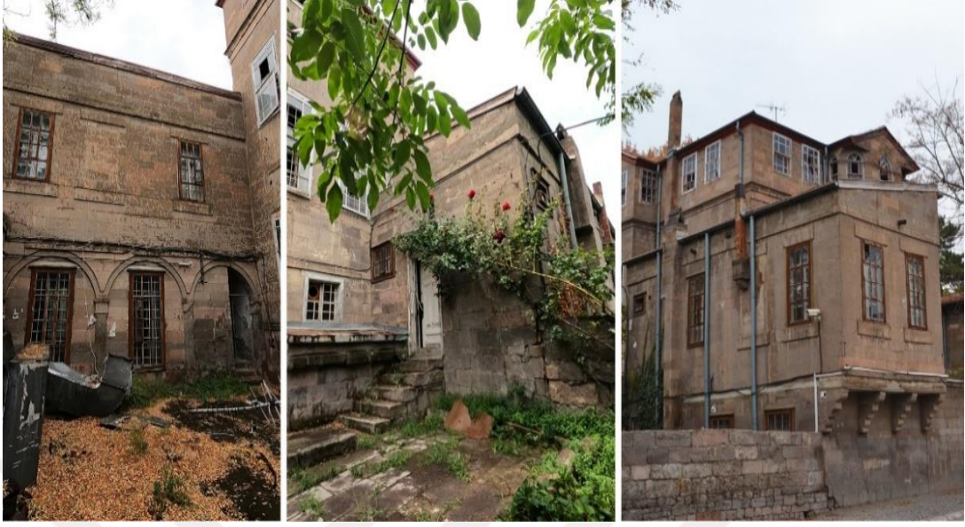
Görsel 4.10. Talas Amerikan Kız Okulu Yerleşkesi; Anaokulu (1), Güney-Doğu-Kuzey ve Batı Cephesi (Suvay, 2021)
