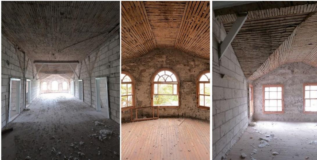
Görsel 4.8. Talas Amerikan Kız Okulu Çatı Arası Mekânlarının Oluşturduğu İkinci Kat (Suvay, 2021)
