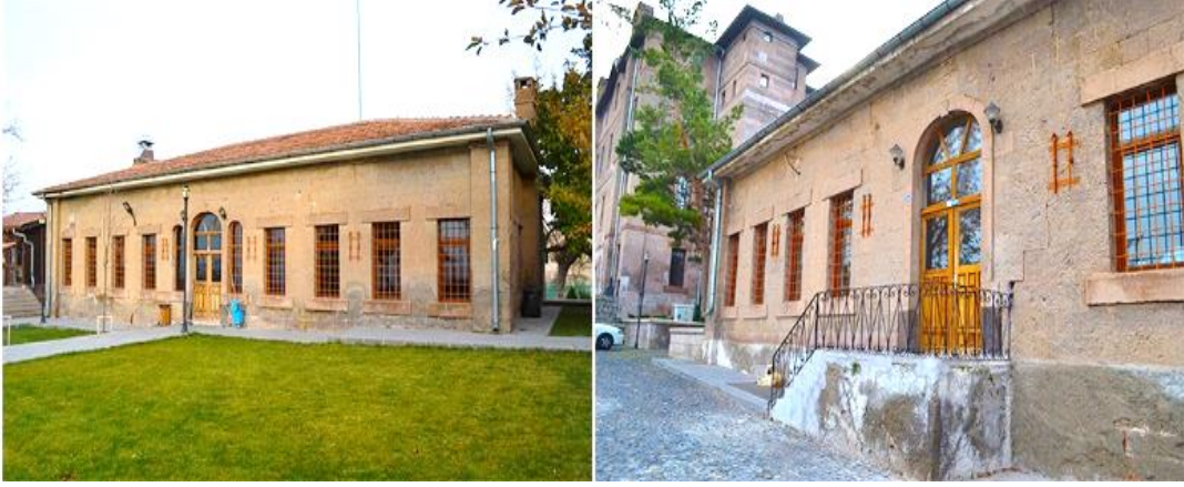
Görsel 4.35. Talas Amerikan Erkek Okulu Yerleşkesi Atölye Yapısı (Suvay, 2021)
