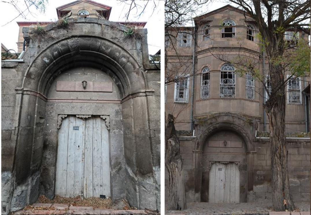
EK-2: Talas Amerikan Kız Okulu Atatürk Bulvarından Avluya Giriş Kapısı (Suvay, 2021)
