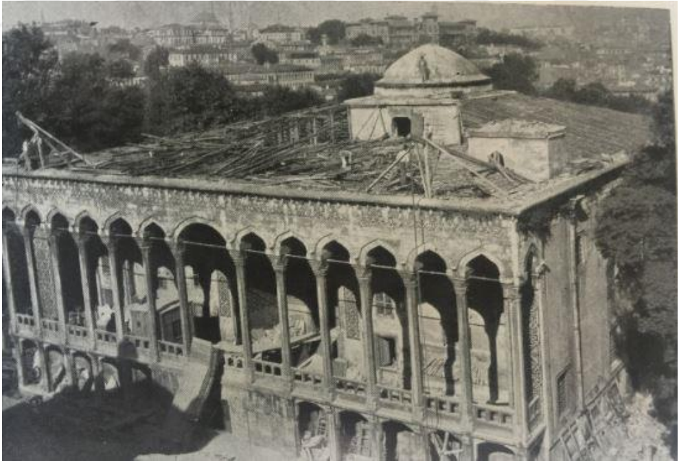
Görsel 3.33: Çinili Köşk'ün çatısı onarımı, Tahsin Öz, 1942
