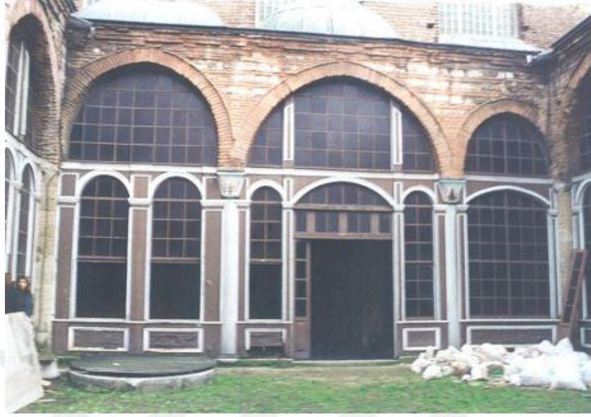
Görsel 3.10: Aya İrini atriuma bakan kemer boşluklarının ahşap doğrama yapılmış hali,İRAMA, 2000
