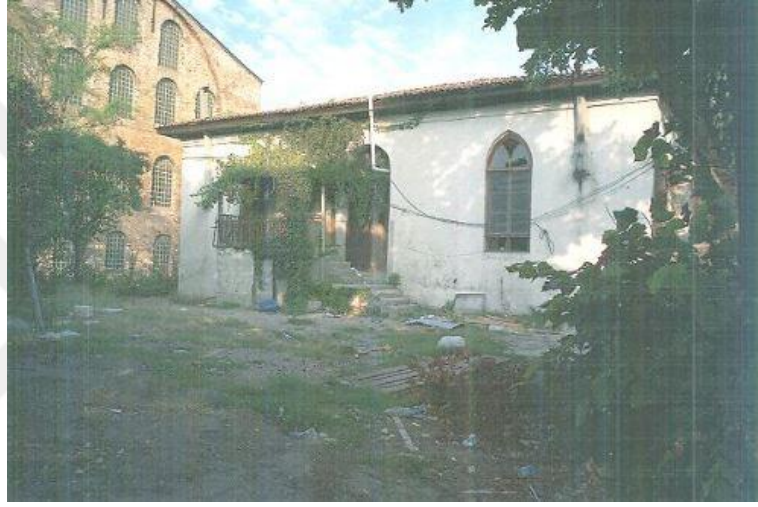
Görsel 3.77: Karakolhane batı cephesi, 2008 onarımı öncesi, İRAMA
