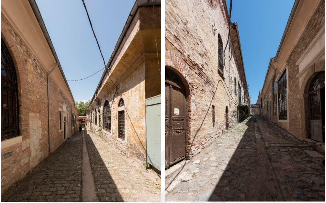
Görsel 3.62: Kalıp Atölyesi ve Çarkhane (3 ve 11 numaralı yapılar), TSMA, 2021
