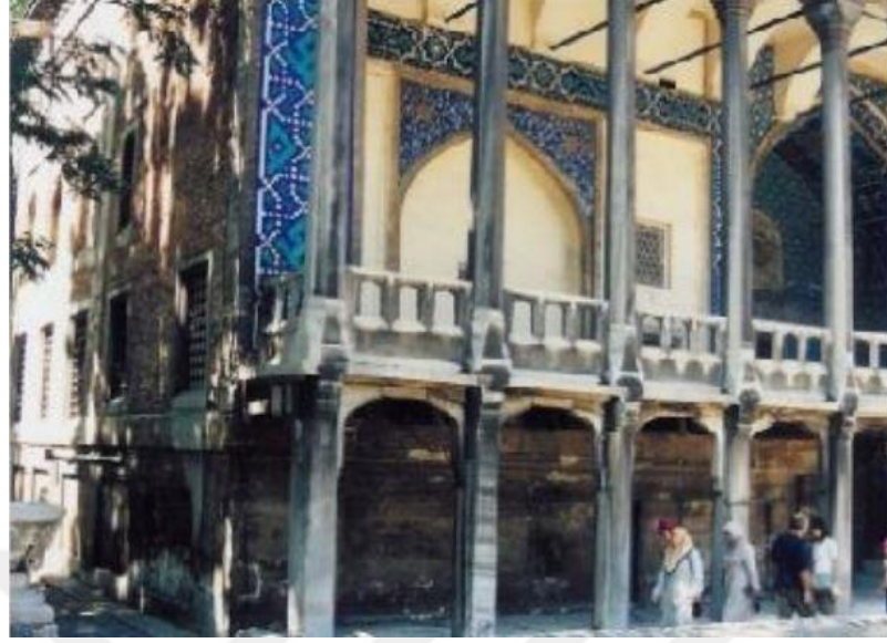
Görsel 3.35: Çinili Köşk doğu cephesinin onarım öncesi görünümü, 2002, İRAMA
