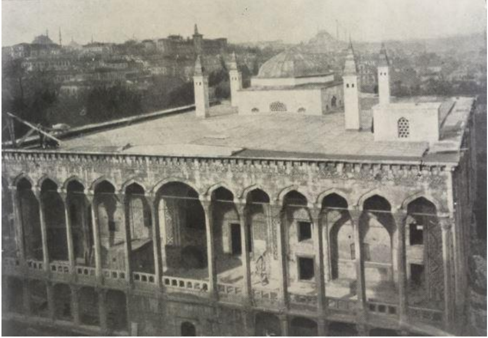
Görsel 3.32: Çinili Köşk'ün çatı onarım öncesi, Tahsin Öz, 1942
