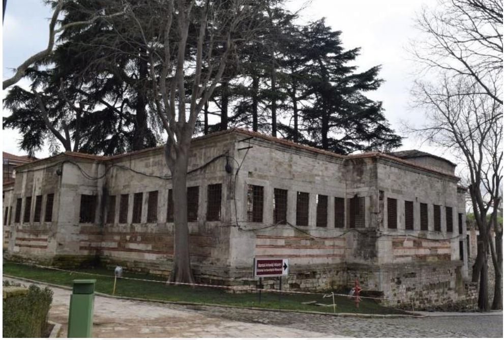
Görsel 3.61: Darphane Köşkü'nün zemin kat duvarları (Kurtçu, 2021)
