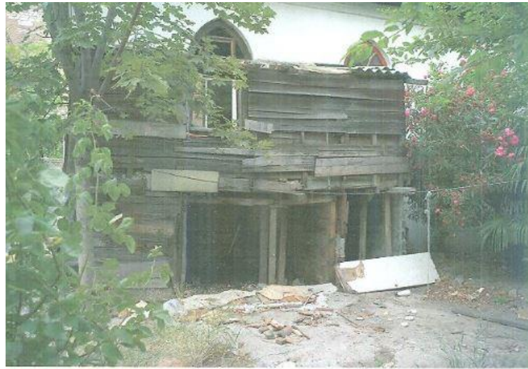
Görsel 3.78: Karakolhane batı cephesi, 2008 onarımı öncesi, İRAMA
